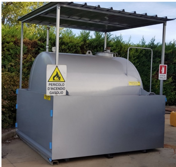
Figura 45 – Esempio di skid per stoccaggio e rifornimento gasolio e di container per stoccaggio sostanze pericolose
