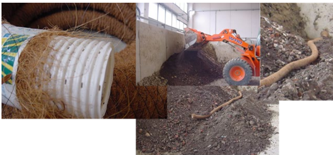
Figura 7 - Fasi di preparazione di una biopila
