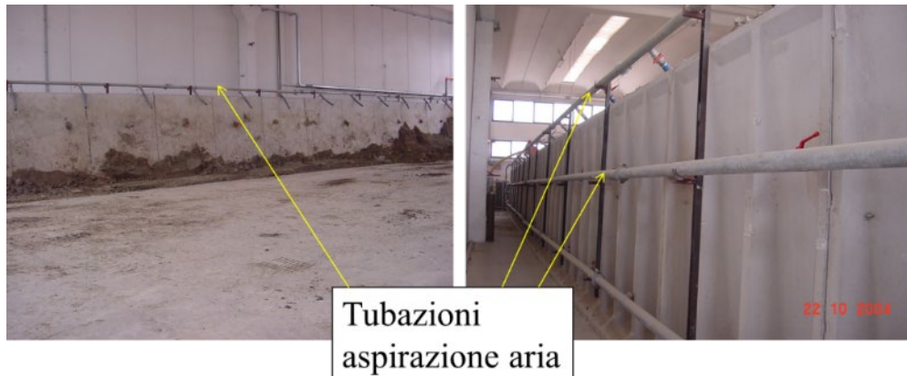
Figura 8 – Immagini di una baia di trattamento mediante bioremediation
