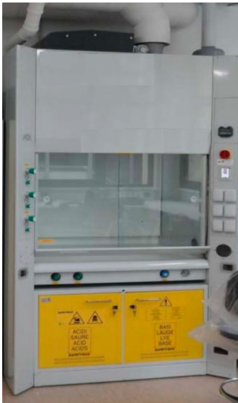
Figura 2 – vista prospettica dell'aspirazione localizzata con cappa chimica
