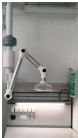
ASPIRAZIONI LOCALIZZATE TIPO "BRACCI" O "PROBOSCIDI"
