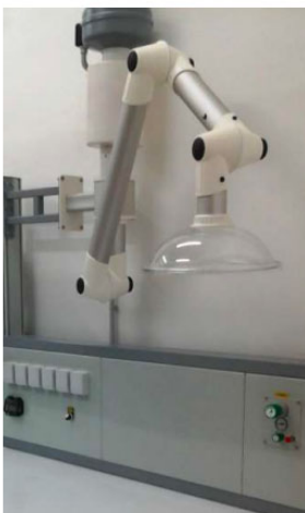
ASPIRAZIONI LOCALIZZATE TIPO "BRACCI" O "PROBOSCIDI"
