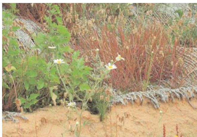
biorete in juta utilizzata per ridurre l'erosione superficiale del deposito appena realizzato
