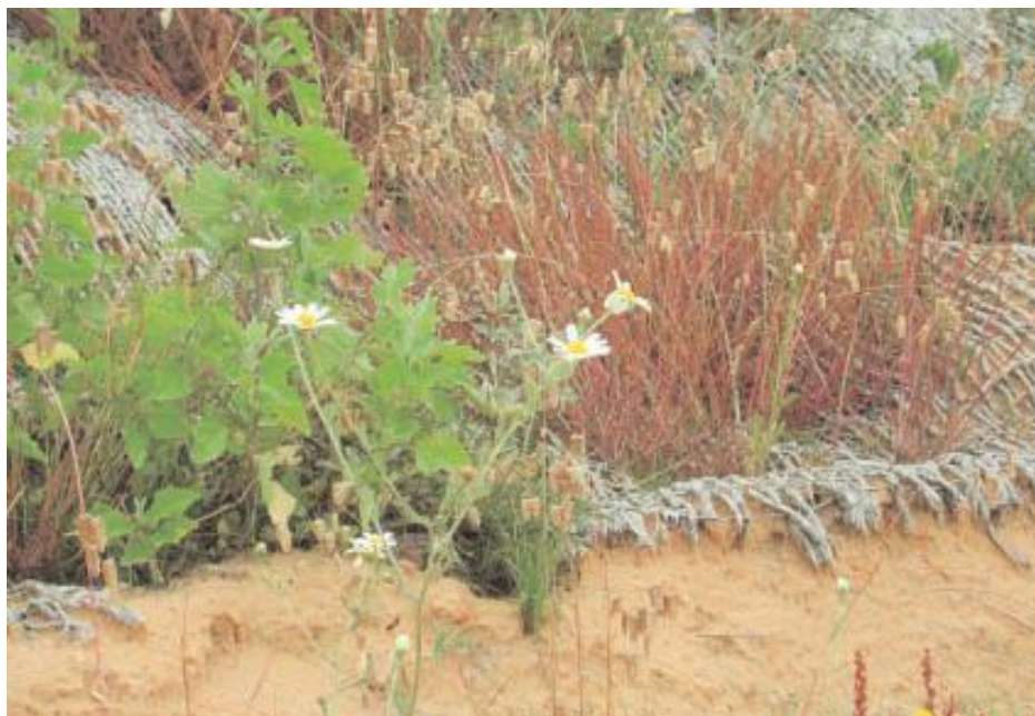
Fig. 3.2.2 - Immagine di biorete in juta utilizzata per ridurre l'erosione superficiale del deposito appena realizzato
