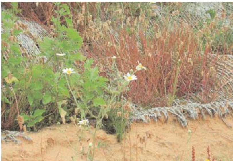
Figura 4-13 Immagine di biorete in juta utilizzata per ridurre l'erosione superficiale del deposito
