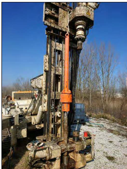
Fig. 19. Esecuzione delle prove SPT all'interno del sondaggio BH-02.
