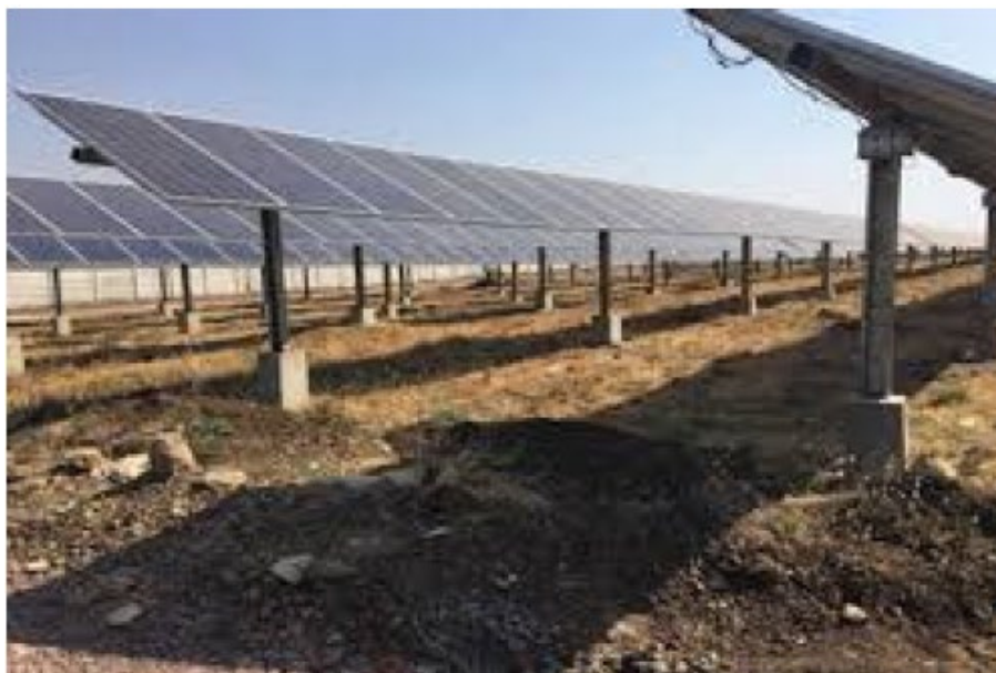
Figura 55. Esempio di impianto fotovoltaico con fondazioni ottenute mediante perforazione del terreno e successiva creazione del palo di fondazione con getto di cemento.
