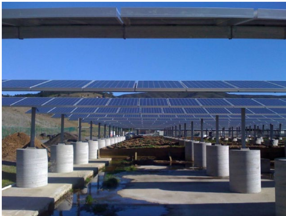
Figura 56. Esempio di impianto fotovoltaico con fondazioni formate da zavorre costituite da plinti in cemento
