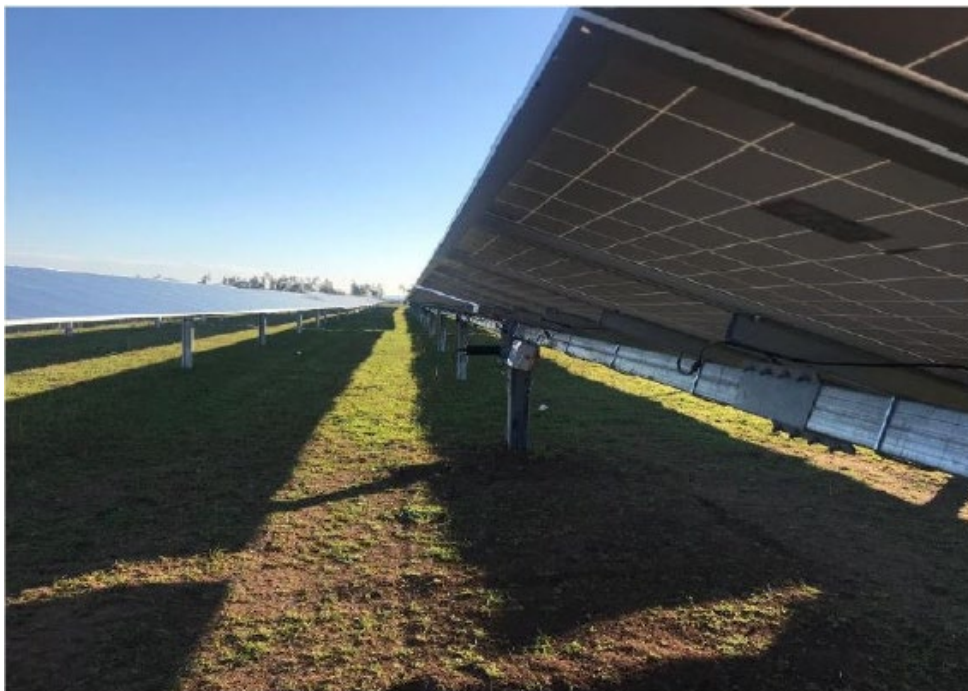
Figura 54. Esempio di impianto fotovoltaico realizzato con supporti costituiti da pali in acciaio infissi direttamente nel terreno
