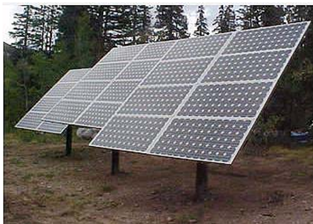
Figura 7: Inseguitore di tilt
