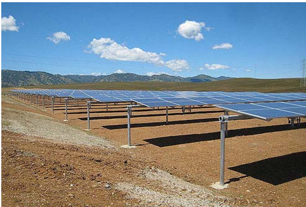
Figura 9: inseguitore di rollio
