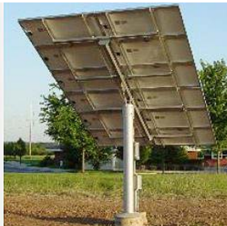
Figura 8 : Inseguitore di tilt
