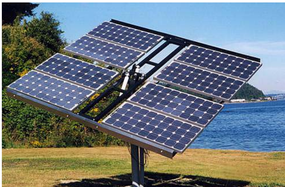
Figura 10: inseguitore di azimut
