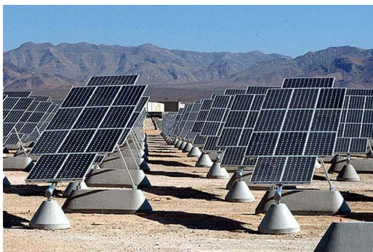
Figura 6: impianto fotovoltaico ad inseguitore monoassiale
