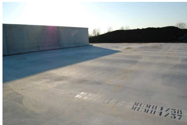
Fig.28 - Area di premiscelazione; nella fotografia si possono notare gli Ecobin e le piastre numerate con le giunzioni tra ogni elemento
