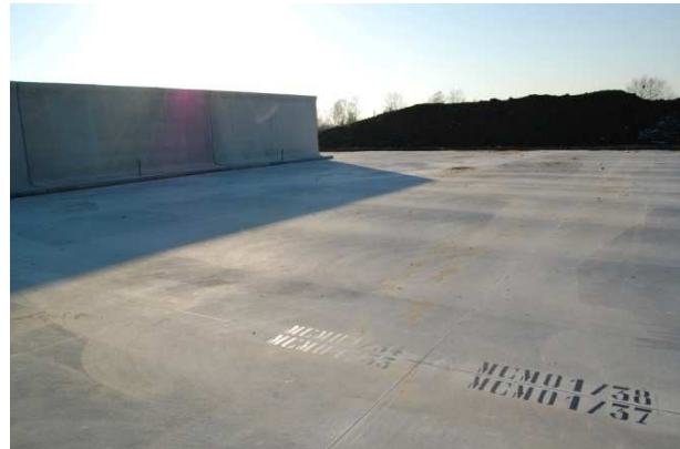
Fig.5 - Area di premiscelazione; nella fotografia si possono notare gli Ecobin e le piastre numerate con le giunzioni tra ogni elemento
