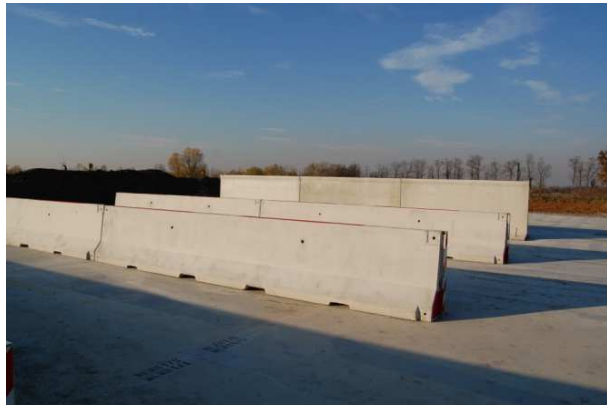
Fig.4 - Comparti di pesatura divisi dai New-Jersey
