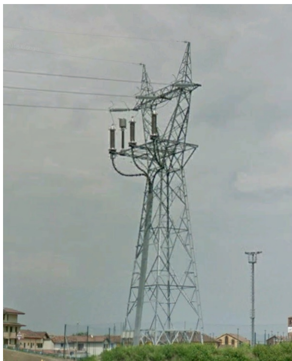
Palo predisposto con la piattaforma per la transizione aereo-cavo per una linea 220 kV
