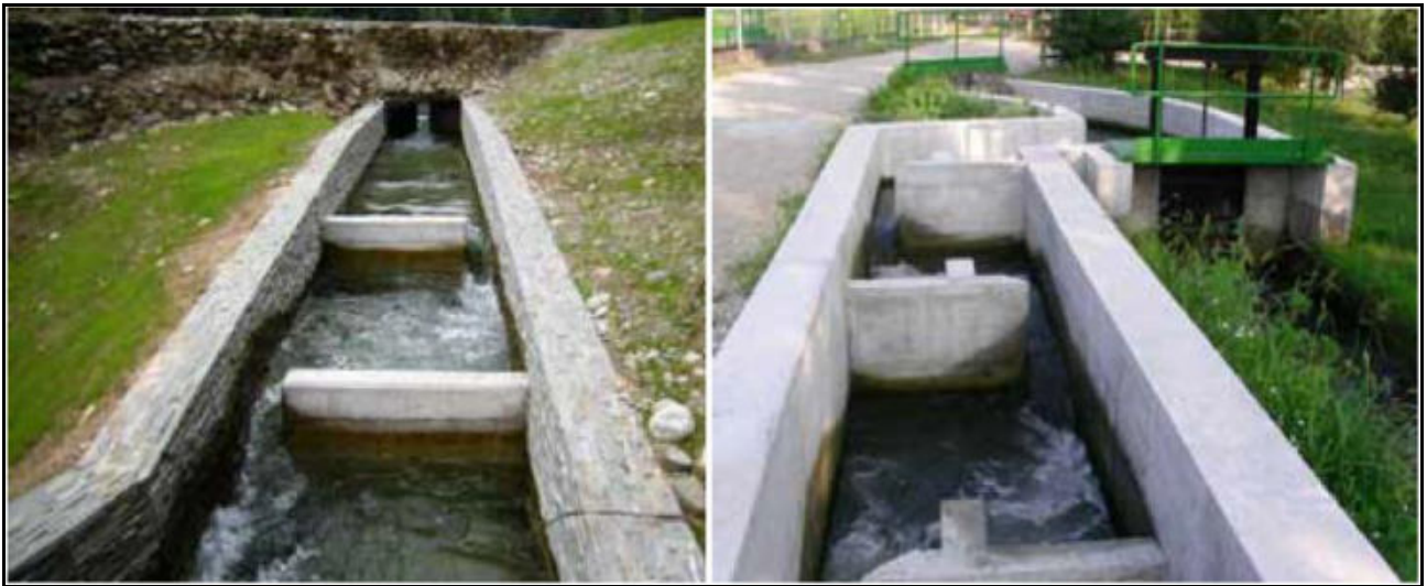
Figura 1.11: esempi di tipologie di passaggi per pesci a slot verticali
