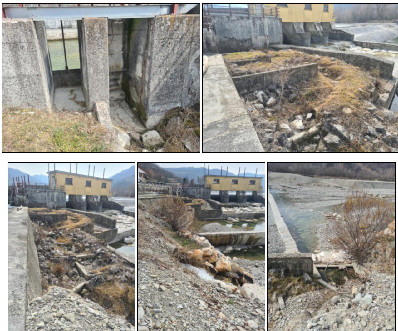
Figura 1.7: stato attuale del PPP sulla traversa di Cerezzola
