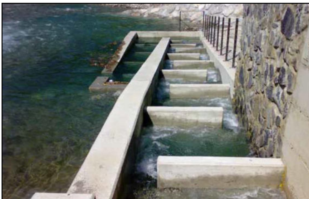
Figura 1.14 : esempio di progettazione cautelativa di imbocco di valle sommerso e sviluppo con ritorno al fine di abbassare la pendenza interna del passaggio. (GRAIA, 2011)
