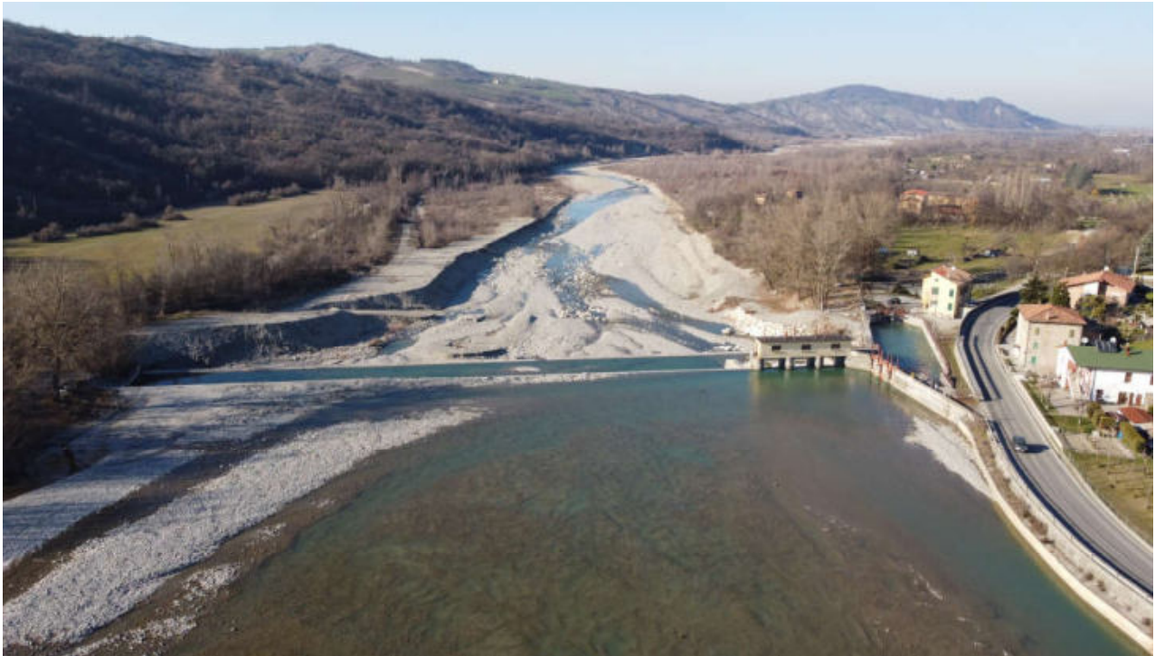
Veduta ravvicinata della traversa di Cerezzola e del contermino contesto paesaggistico (proiezione della veduta verso valle, in direzione nord). Ben visibile , a lato della sponda destra, la strada provinciale che è esposta a rischio allagamento in caso di forti piene.
