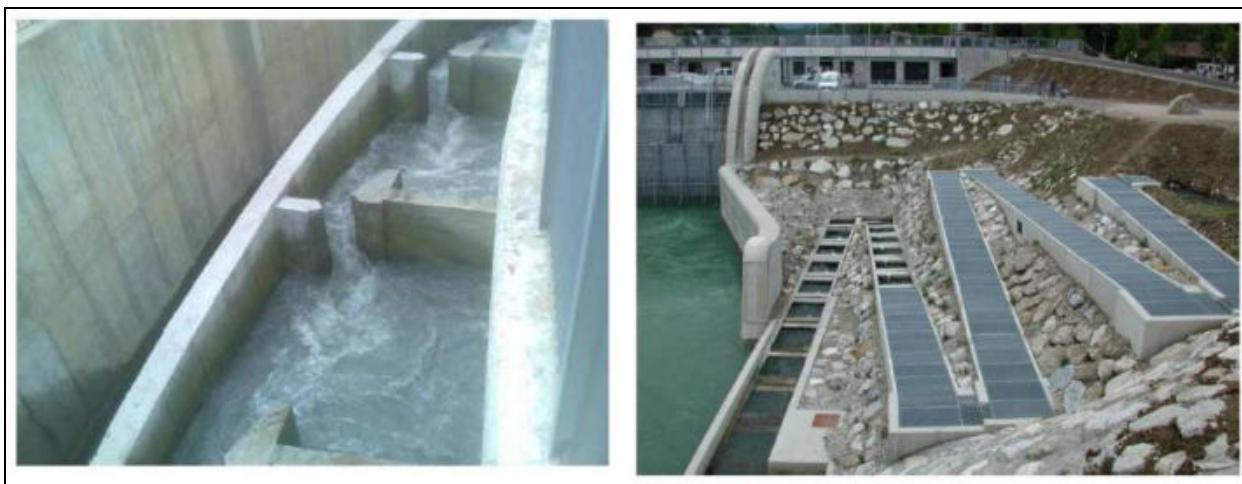
Figura 1.17 : esempi analoghi di passaggi a slot verticali con grigliato di copertura per protezione
