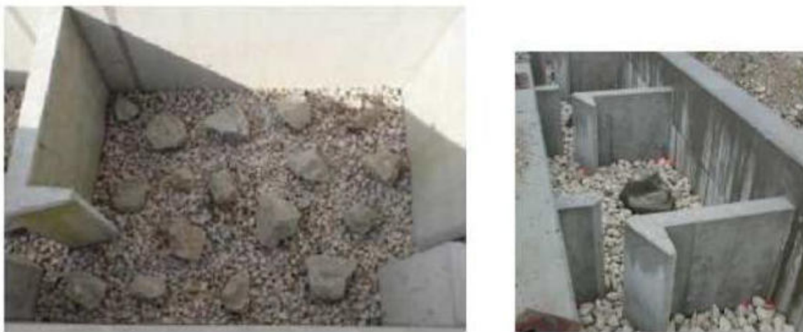
Figura 1.19 : esempi di substrato di fondo in una vertical slot (da Zitek, 2011 e Rucker e Wittmann, 2005)
