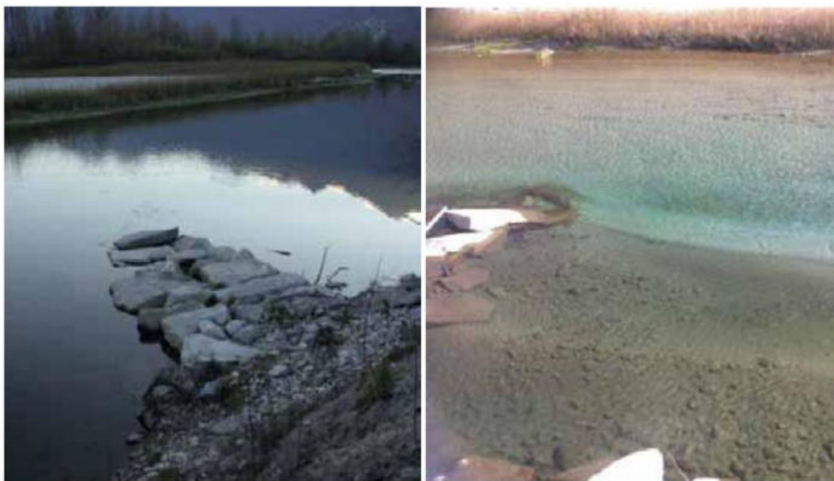
Figura 11.6: esempio di interventi realizzati con pennelli o repellenti
