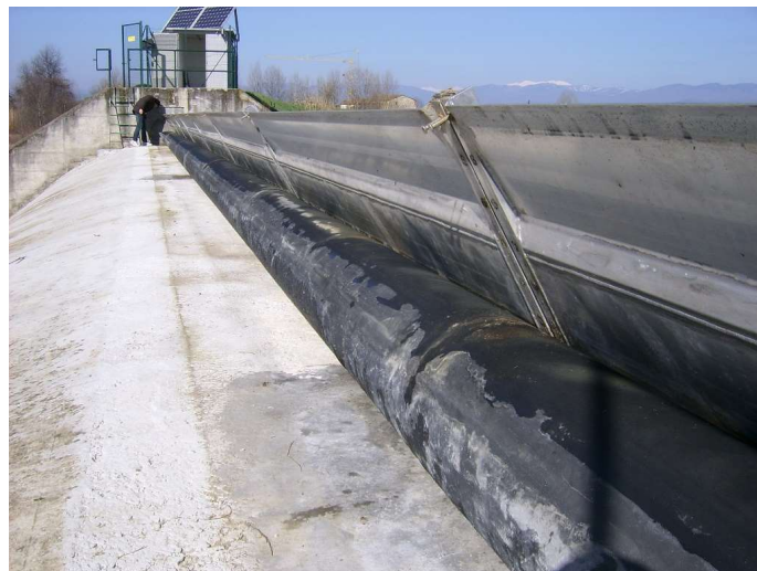
Figura 13: Sbarramento gonfiabile alzato (pallone gonfiato e scudo metallico alzato)
