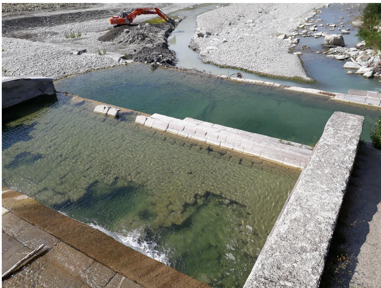
Figura 34: ripresa fotografica dal soprastante edificio sghiaiatore della vasca dissipatrice originaria di lunghezza insufficiente
