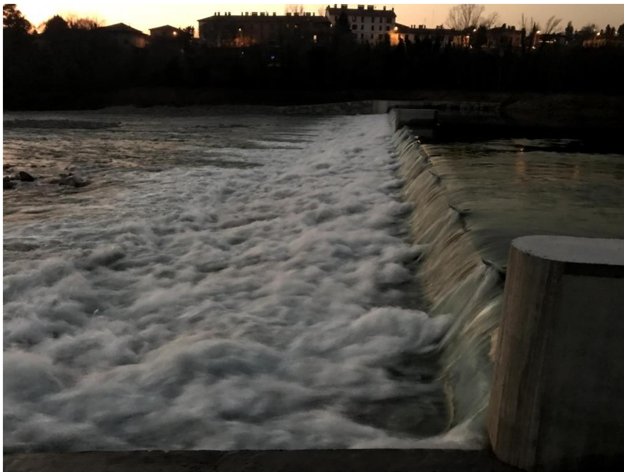
Figura 46: esempio di riduzione dell'impatto paesaggistico dello sbarramento per sfioro sommitale di una portata con contestuale funzione di rilascio minimo vitale.
