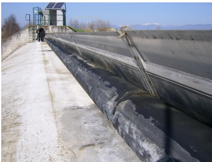
Figura 45: Sbarramento gonfiabile alzato (pallone gonfiato e scudo metallico alzato)
