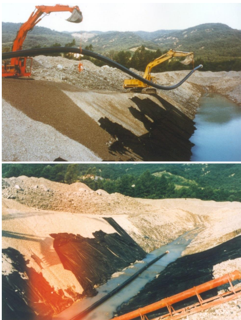
Figura 13: posa della condotta drenante
