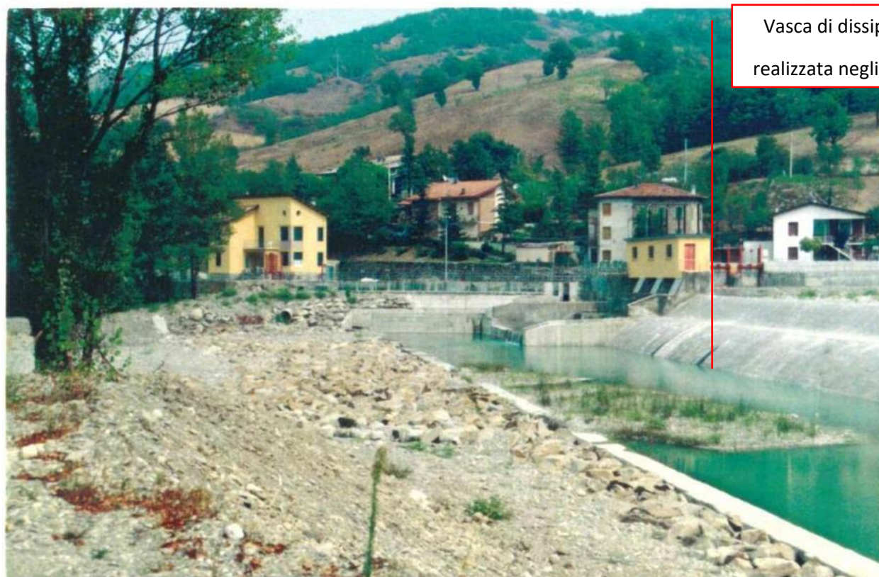
Figura 8: vista della vasca di dissipazione a fine lavori
