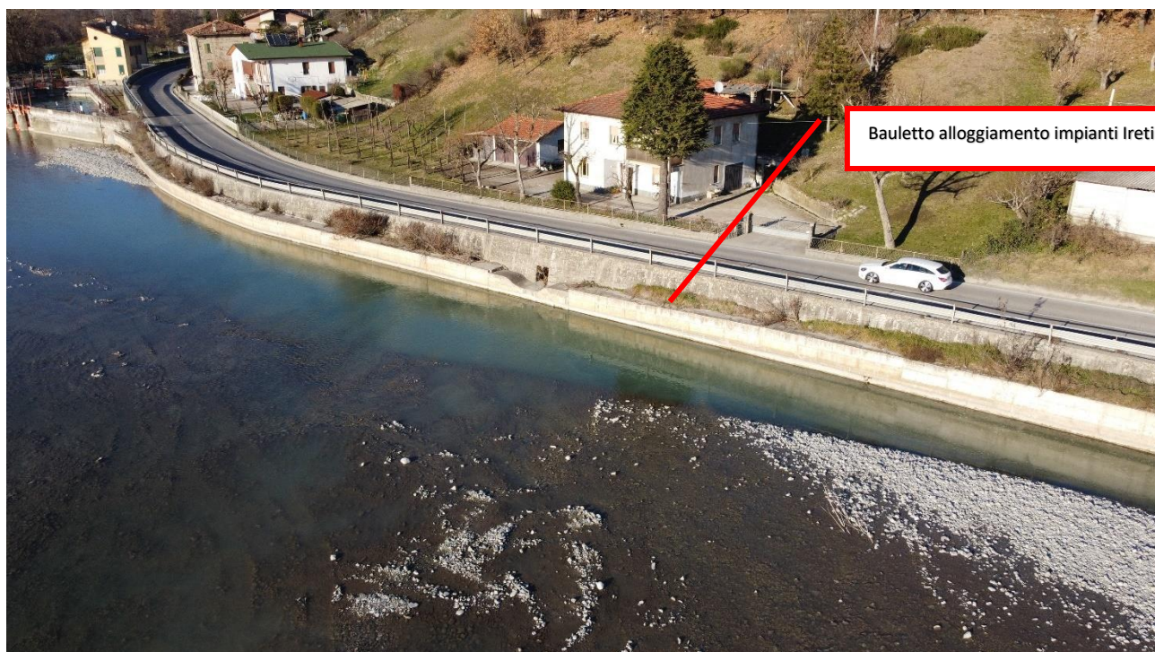
Figura 85: vista dell'area ove la condotta ireti risulta esposta a fiume
