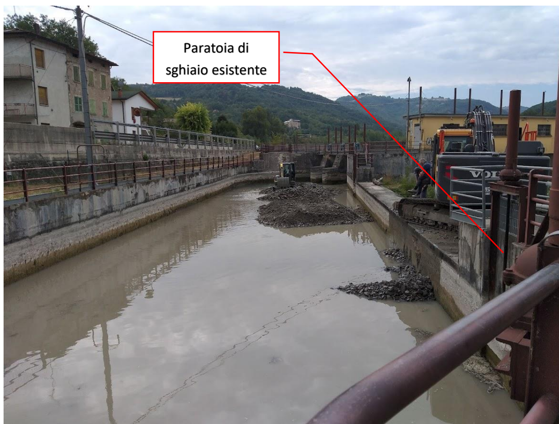
Figura 63: operazioni di pulizia della vasca dissabbiatrice
