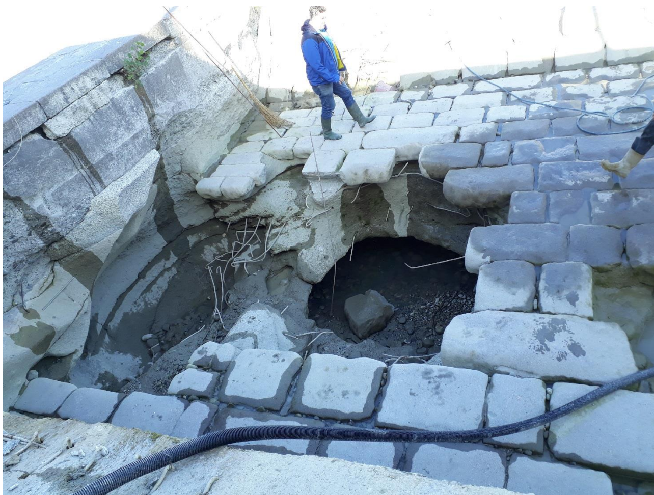
Figura 36: evidenza della voragine formatasi a seguito della continuativa azione erosiva dell'acqua e degli urti del materiale solido trasportato sul solaio immediatamente a valle delle paratoie sghiaiatrici
