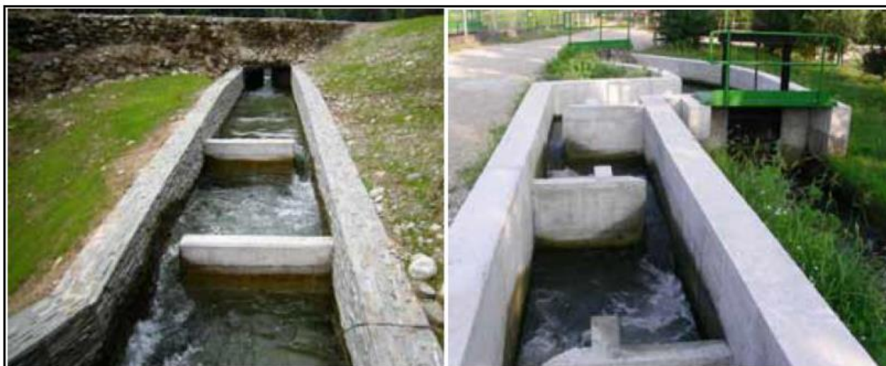
Figura 67: esempio di passaggio per pesci a bacini successivi vertical slot
