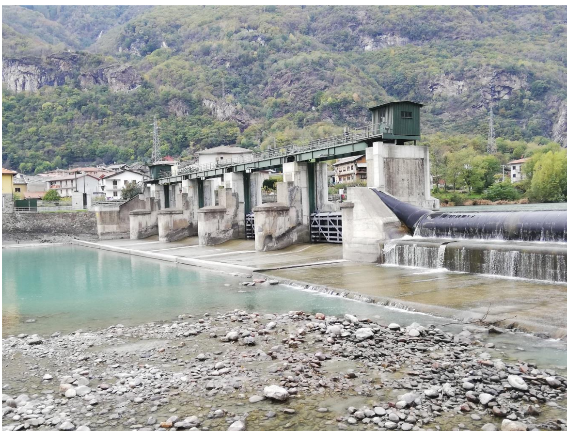
Figura 44: sbarramento in località Quincinetto (TO) sulla dora Baltea realizzato con tecnica mista (paratoie piane tradizionali + paratoia gonfiabile)
