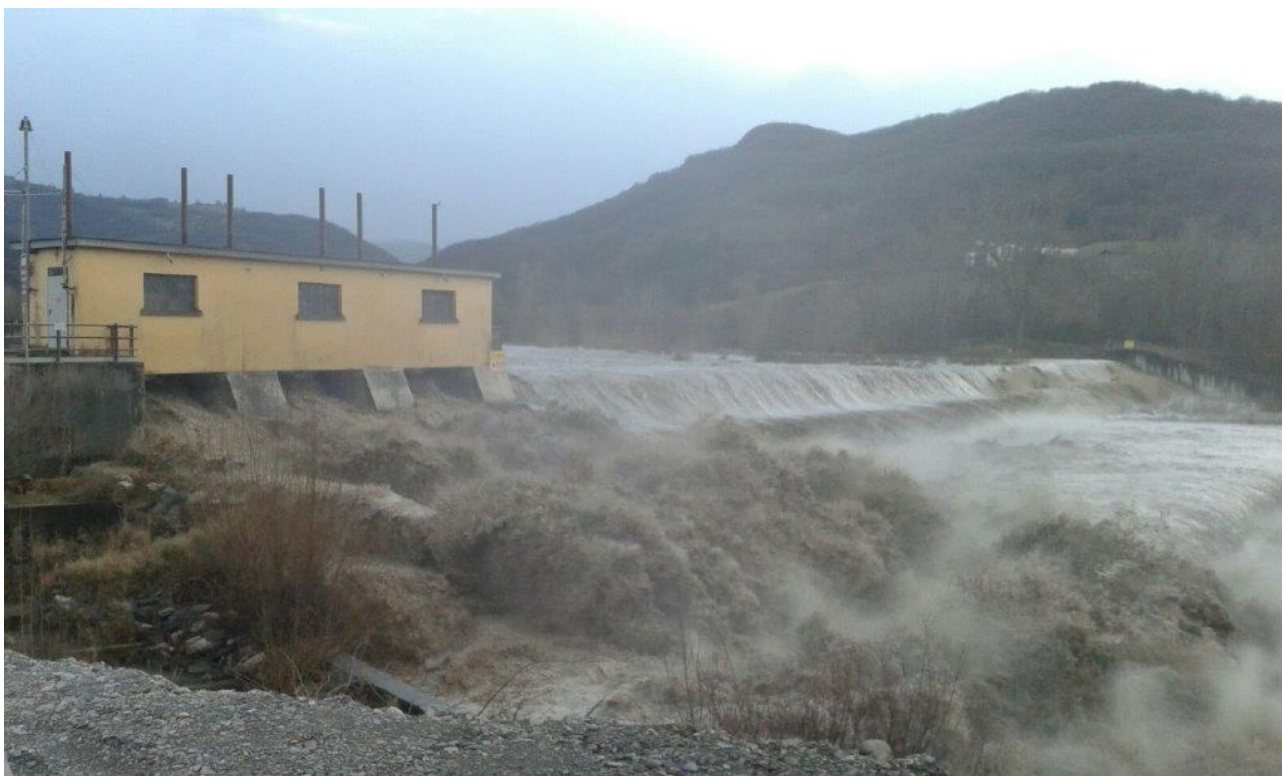
Figura 35: ripresa fotografica della zona della vasca dissipatrice immediatamente a valle dell'edificio sghiaiatore con evidenza della forte turbolenza
