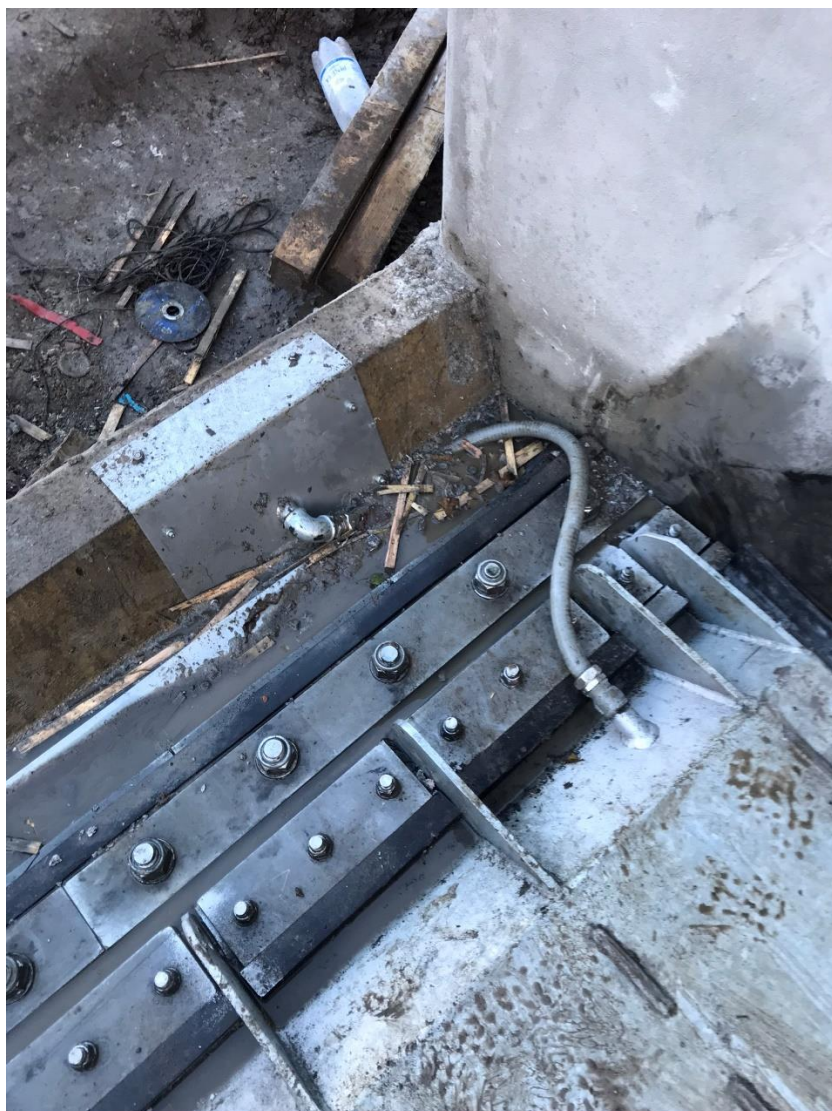
Figura 49: particolare della cerniera in fase di installazione
