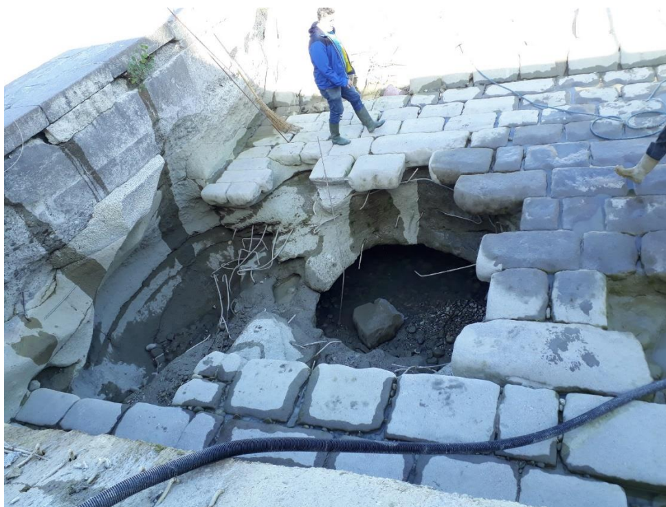
Figura 22 - Evidenza della voragine formatasi a seguito della continuativa azione erosiva dell'acqua e degli urti del materiale solido trasportato sul solaio immediatamente a valle delle paratoie sghiaiatrici.
