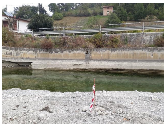
Figura 15 - Riprese fotografiche da fiume del paramento del muro della strada provinciale su cui sono evidenti gli scarichi esistenti.
