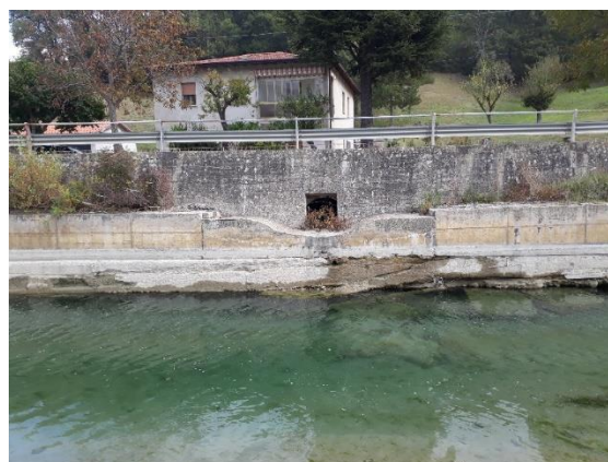
Figura 15 - Riprese fotografiche da fiume del paramento del muro della strada provinciale su cui sono evidenti gli scarichi esistenti.
