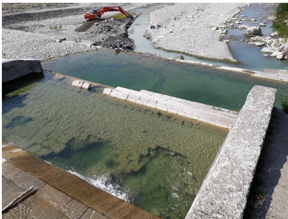
Figura 21 - Ripresa fotografica dal soprastante edificio sghiaiatore della vasca dissipatrice originaria di lunghezza insufficiente.
