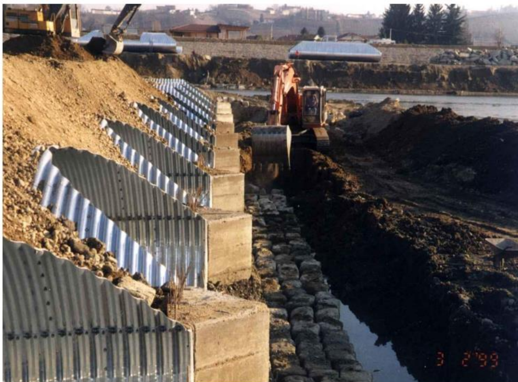
Figura 12: particolare dell'invito per ingresso acqua in condotta
