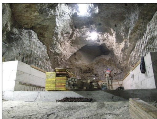
Foto 1: Fase di realizzazione della centinatura
