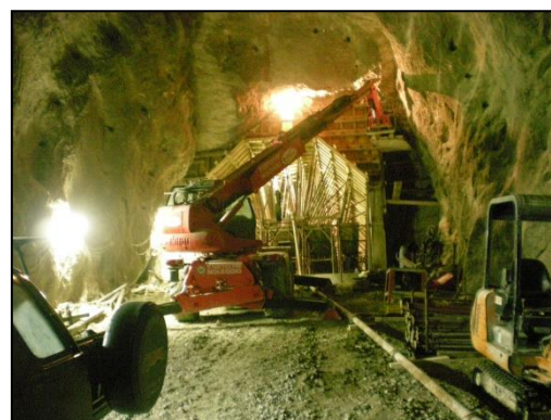
Foto 2: Fase di realizzazione della centinatura
