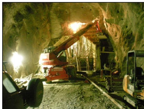
Foto 2: Fase di realizzazione della centinatura
