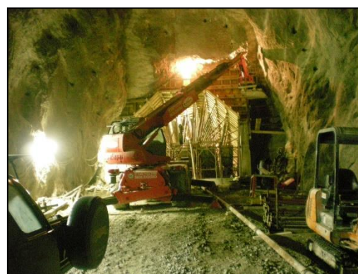
Foto 2: Fase di realizzazione della centinatura
