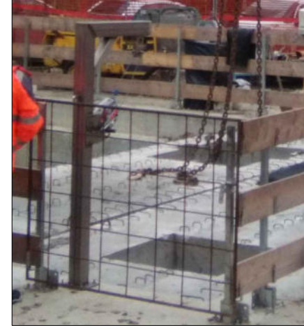
ESEMPIO RECUPERATORE E PARAPETTO PERIMETRALE CON CANCELLETTO
