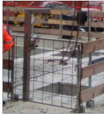
ESEMPIO RECUPERATORE E PARAPETTO PERIMETRALE CON CANCELLETTO
