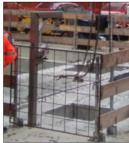
ESEMPIO RECUPERATORE E PARAPETTO PERIMETRALE CON CANCELLETTO
