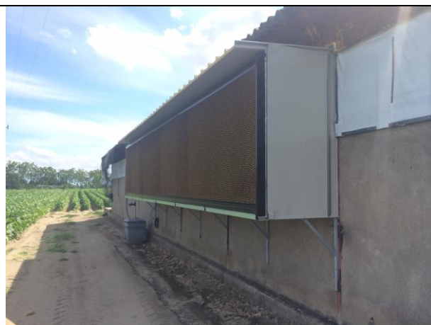
Sistema di raffreddamento estivo pad cooling
