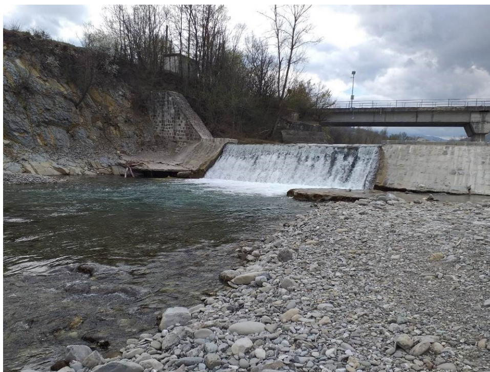
Figura 5– Particolare briglia esistente, vista da valle (destra idraulica).
