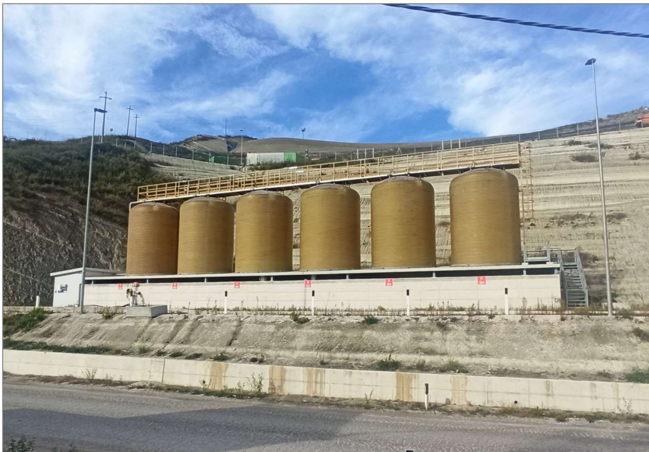
Figura 13 – Foto dei serbatoi di stoccaggio del percolato attualmente presente e in uso, a valle di G4, identico a quello in progetto per G3.
