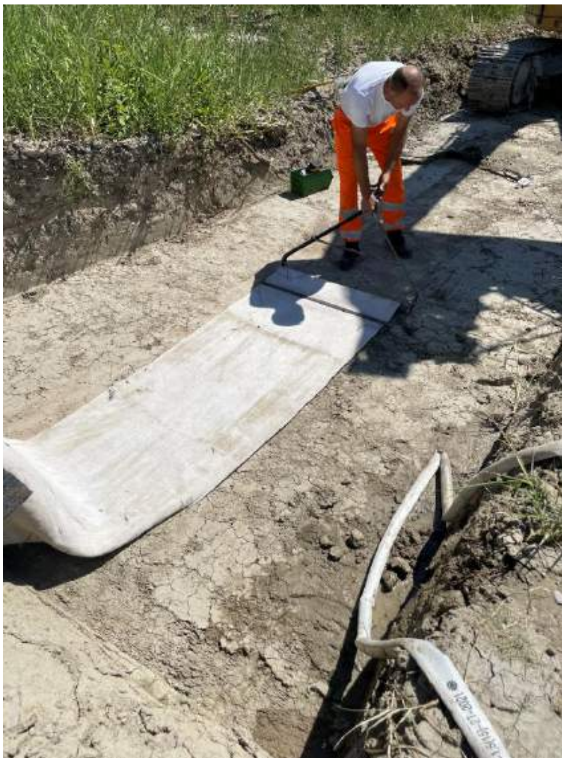
Fig. 3-2 Collocazione del geocomposito.
