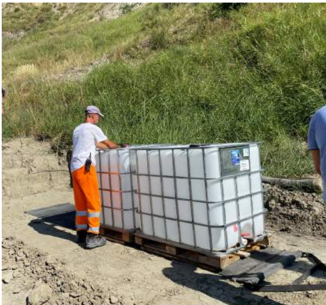
Fig. 3-3 Geocomposito e sistema di carico.
