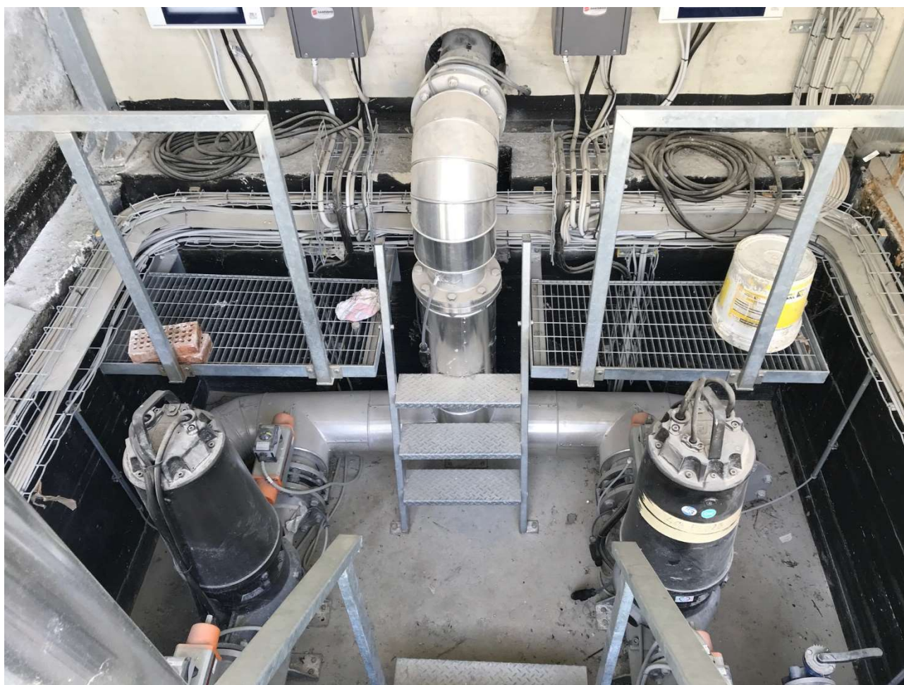
Figura 2 – Esempio di gruppo di pompaggio da installare sotto battente
