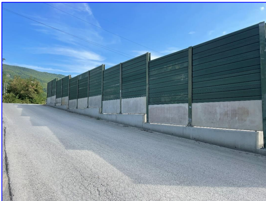
Figura 5 – Barriere acustiche posizionate in corrispondenza al confine sud dello stabilimento, identiche a quelle previste a lato della nuova infrastruttura
