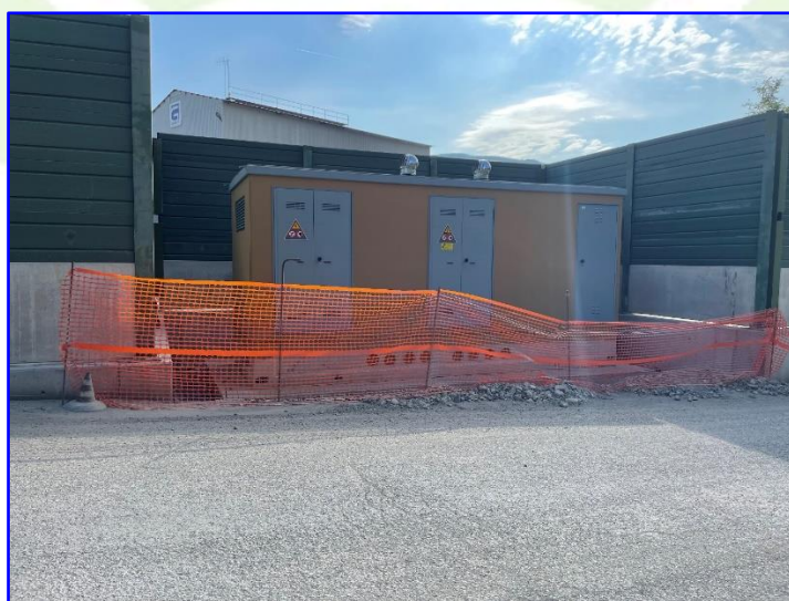
Figura 33 bis – Nuova cabina elettrica integrata nella recinzione perimetrale dello stabilimento
