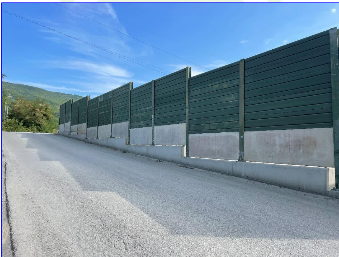
Figura 20 – Barriere acustiche posizionate in corrispondenza al confine sud dello stabilimento, identiche a quelle previste a lato della nuova infrastruttura
