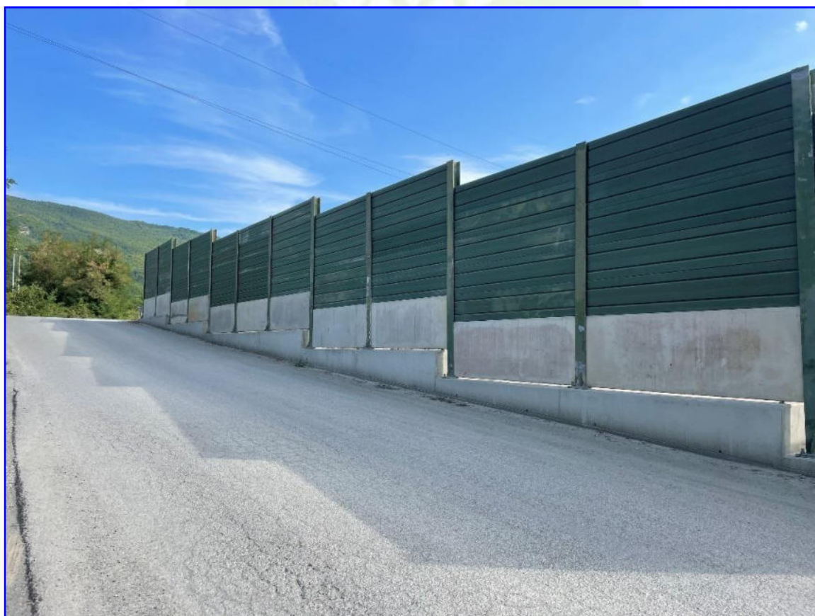
Figura 37 – Barriere acustiche posizionate in corrispondenza al confine sud dello stabilimento, identiche a quelle previste a lato della nuova infrastruttura
