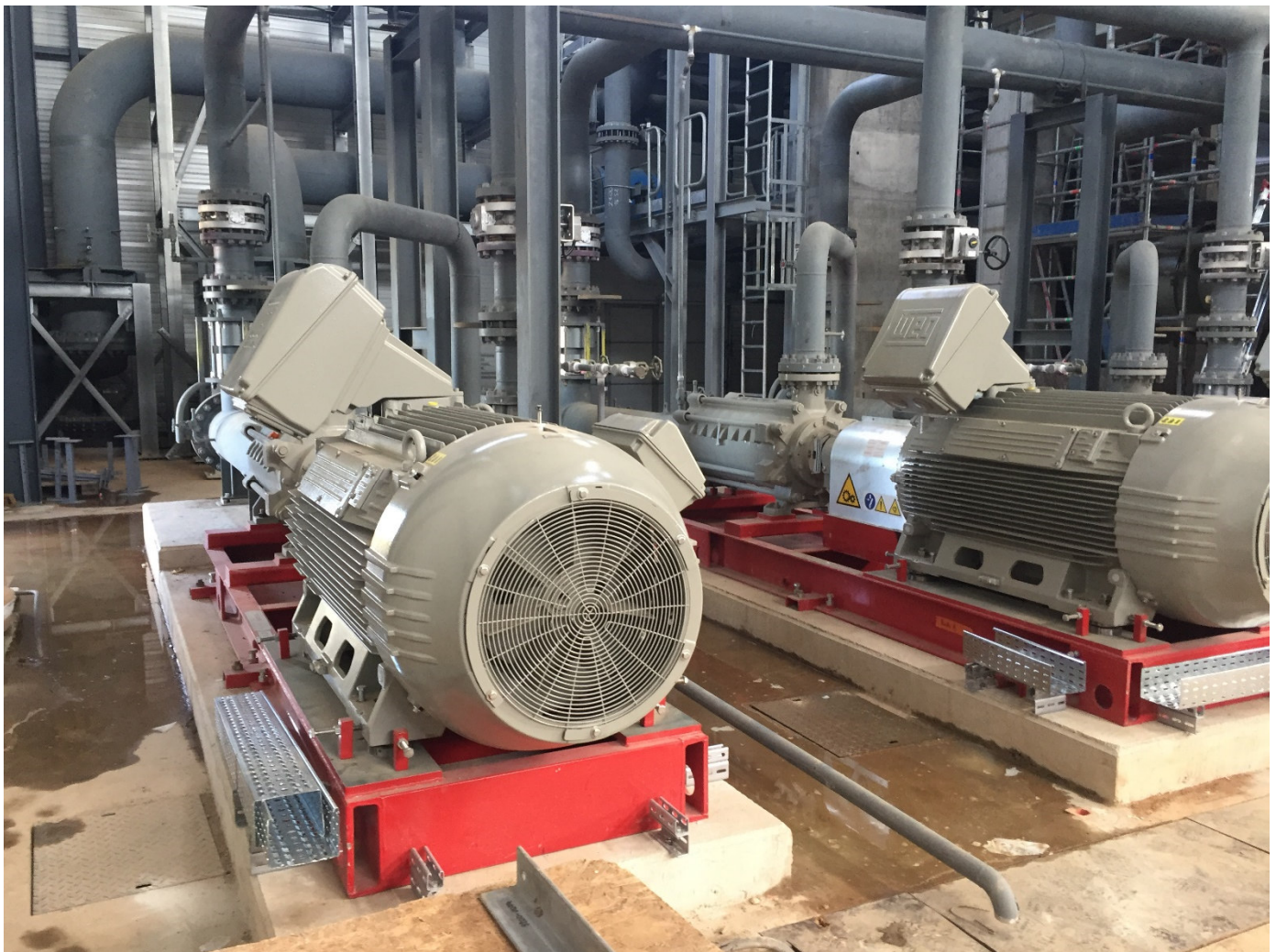
Figura 2: Esempio di pompe per fluido di lavoro (progetto VDH (FR))
