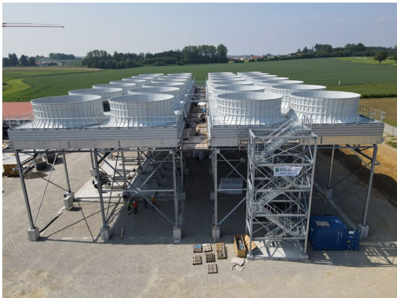
Figura 4: Esempio di condensatore ad aria in fase di costruzione (progetto Kirchweidach (DE)).
