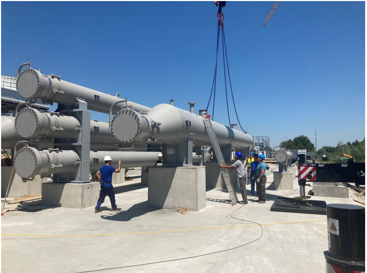
Figura 3: Esempio di preriscaldatori a fascio tubiero in fase di costruzione (progetto Kirchweidach (DE)).
