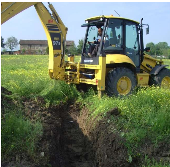
Foto raffigurante la realizzazione della canaletta perimetrale e canaletta a margine esterno della recinzione perimetrale la postazione in una postazione analoga
