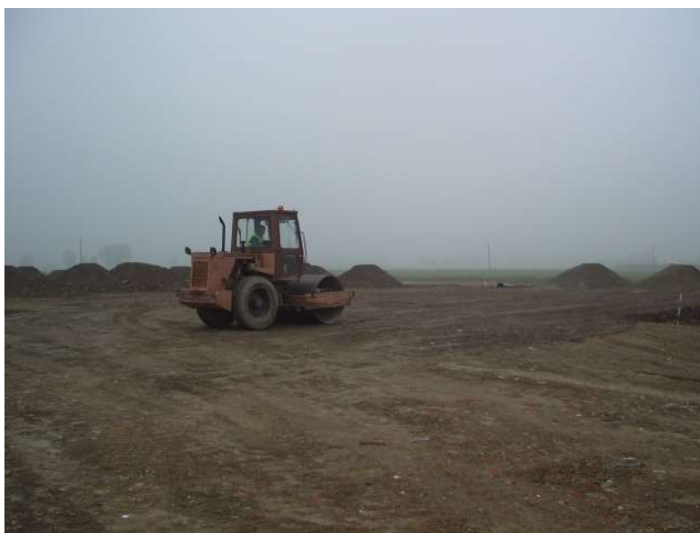
Foto raffigurante fasi di rullatura del piano di posa della massicciata in una postazione analoga
