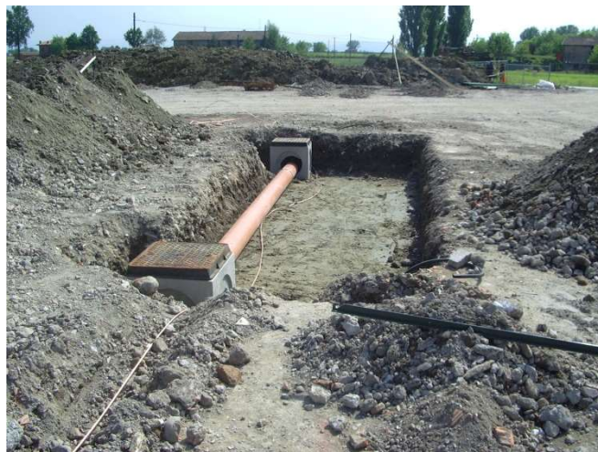
Foto raffigurante la posa della corda di rame della rete di messa a terra delle strutture e dell'impianto di perforazione in una postazione analoga
