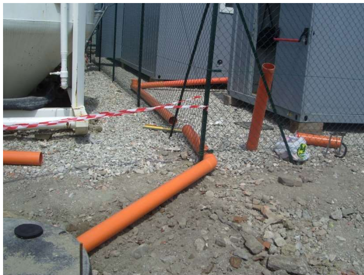
Foto raffigurante la posa della rete di scarichi dei servizi a disposizione degli operatori durante la perforazione: a perfetta tenuta idraulica mediante sigillatura dei giunti delle tubazioni con recapito in fossa IMHOFF a tenuta (in basso a sinistra) in una postazione analoga
