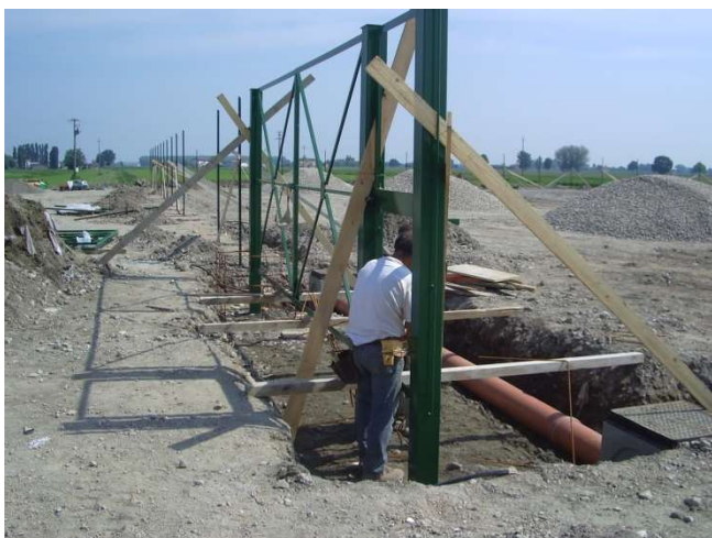
Foto raffigurante la posa della rete di recinzione e dei cancelli in una postazione analoga
