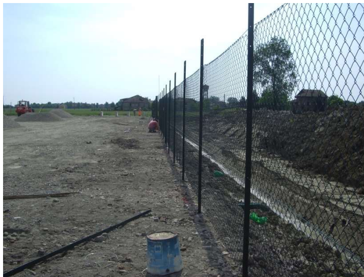
Foto raffigurante la realizzazione della canaletta perimetrale e canaletta a margine esterno della recinzione perimetrale la postazione in una postazione analoga
