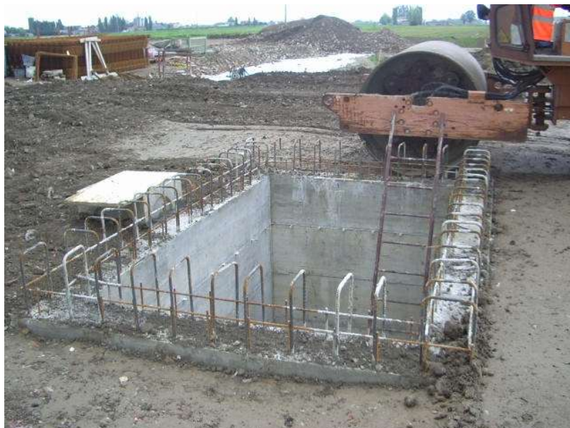
Foto raffigurante fasi di costruzione della cantina per avampozzo in una postazione analoga
