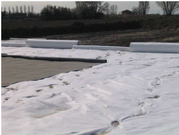
Foto raffiguranti fasi di posa del tessuto non tessuto con all'interno geomembrana sotto la massicciata in una postazione analoga
