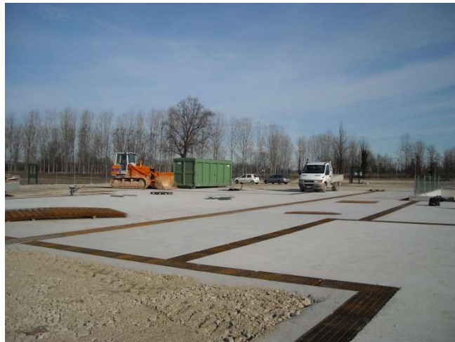
Foto raffigurante le canalette prima e durante la presenza dell'impianto di perforazione: a completa tenuta in una postazione analoga
