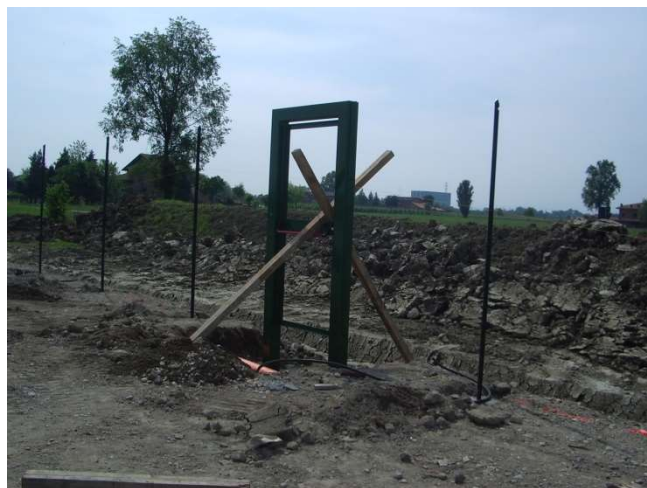
Foto raffigurante la posa del cancello carrabile con cancello pedonale annesso e posa di cancello per vie di fuga con maniglione antipánico in una postazione analoga
