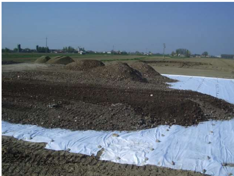
Foto raffigurante la massciata stradale del piazzale durante la realizzazione in una postazione analoga
