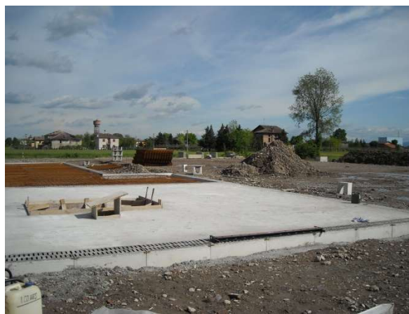
Foto raffigurante fasi di costruzione delle solette in C.A. della sottostruttura impianto, vasche impianto e pompe: completamente impermeabili agli eventuali sversamenti durante la perforazione in una postazione analoga
