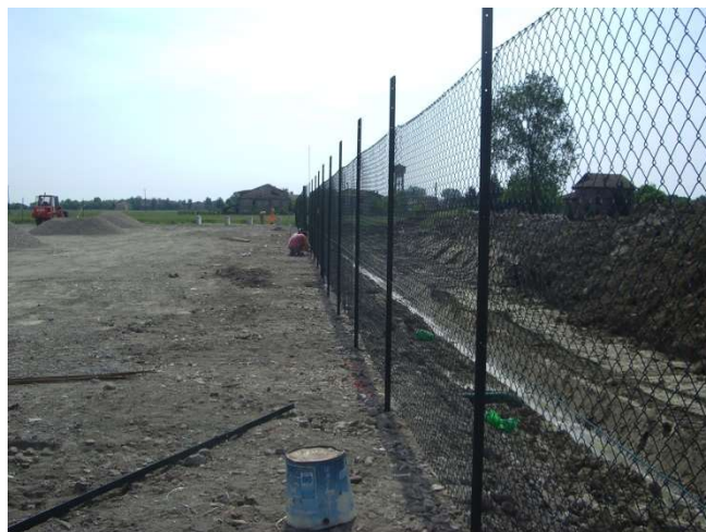
Foto raffigurante la posa della rete di recinzione e dei cancelli in una postazione analoga
