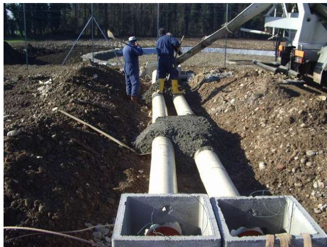
Foto raffiguranti il cunicolo/canalizzazioni di contenimento del tubo del gasolio in una postazione analoga
