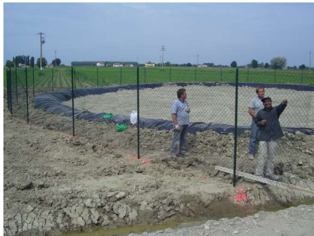
Foto raffiguranti il bacino di contenimento della fiaccola e la realizzazione della recinzione perimetrale in una postazione analoga
