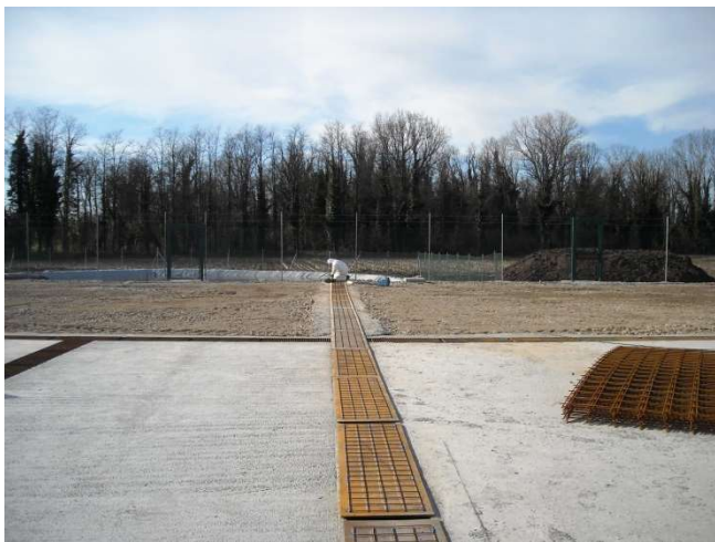
Foto raffiguranti il cunicolo/canalizzazioni di contenimento del tubo del gasolio in una postazione analoga
