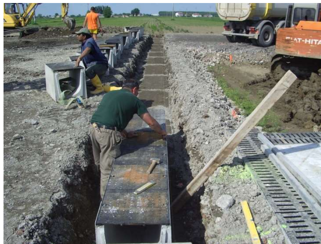
Foto raffigurante la realizzazione di alcune canalizzazioni di servizio all'interno del piazzale in una postazione analoga
