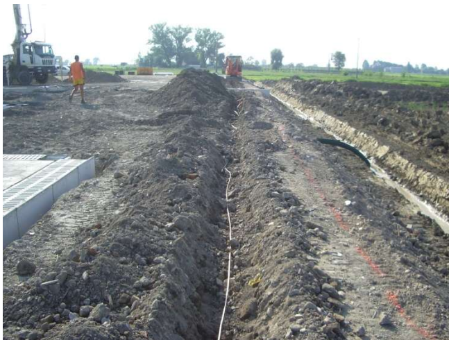
Foto raffigurante la posa della corda di rame della rete di messa a terra delle strutture e dell'impianto di perforazione in una postazione analoga
