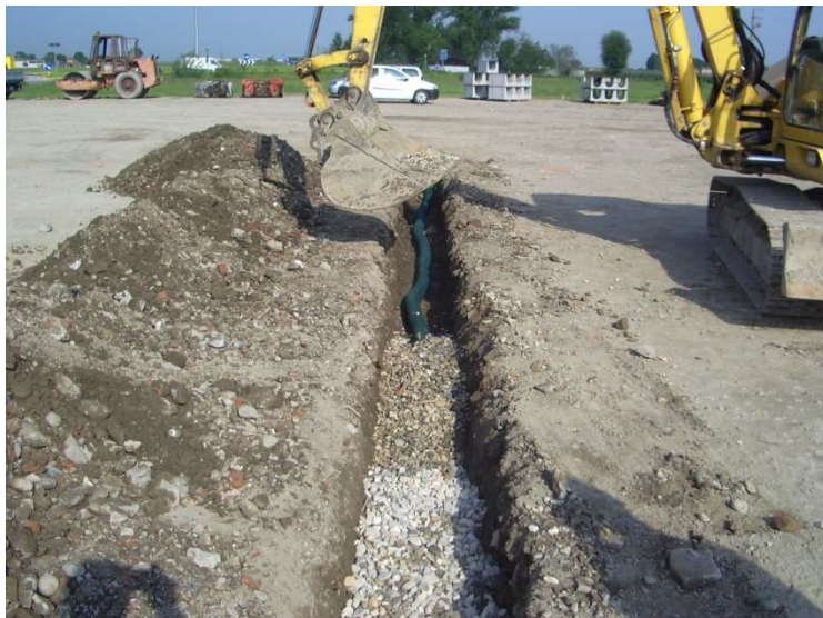
Foto raffigurante la posa dei tubi di drenaggio all'interno della massicciata stradale del piazzale in una postazione analoga
