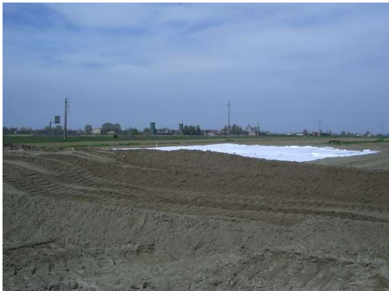
Foto raffigurante lo strato di sabbia a protezione del tessuto non tessuto e della guaina in HDPE, alla base della massicciata in una postazione analoga
