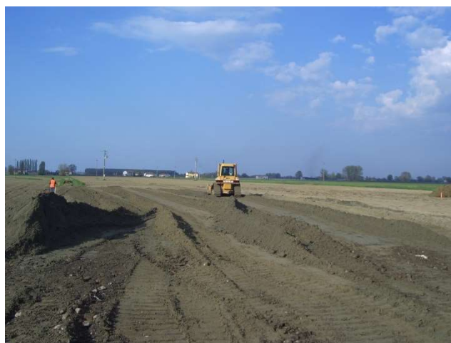
Foto raffigurante fasi di scotico in postazione analoga a quella da realizzare
