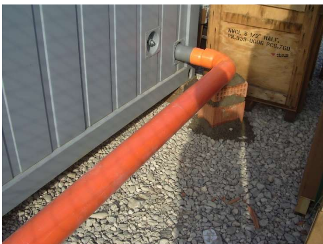
Foto raffigurante la posa della rete di scarichi dei servizi a disposizione degli operatori durante la perforazione: a perfetta tenuta idraulica mediante sigillatura dei giunti delle tubazioni in una postazione analoga
