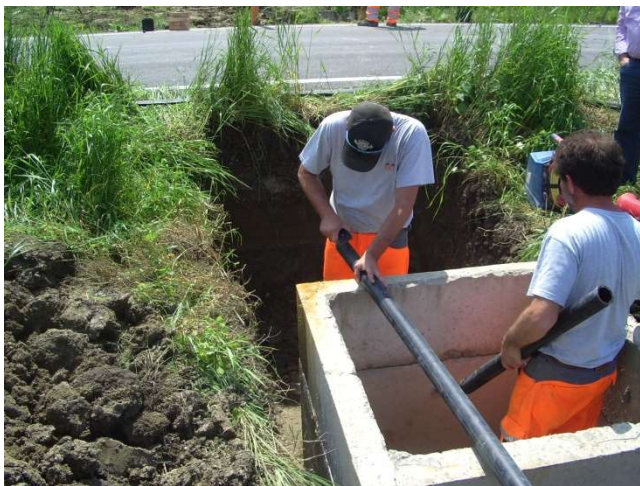
Foto raffigurante la realizzazione di alcune canalizzazioni di servizio all'interno del piazzale in una postazione analoga
