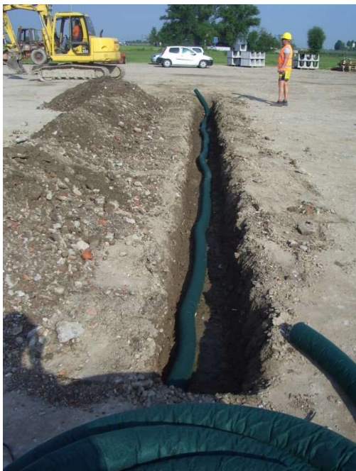
Foto raffigurante la posa dei tubi di drenaggio all'interno della massicciata stradale del piazzale in una postazione analoga
