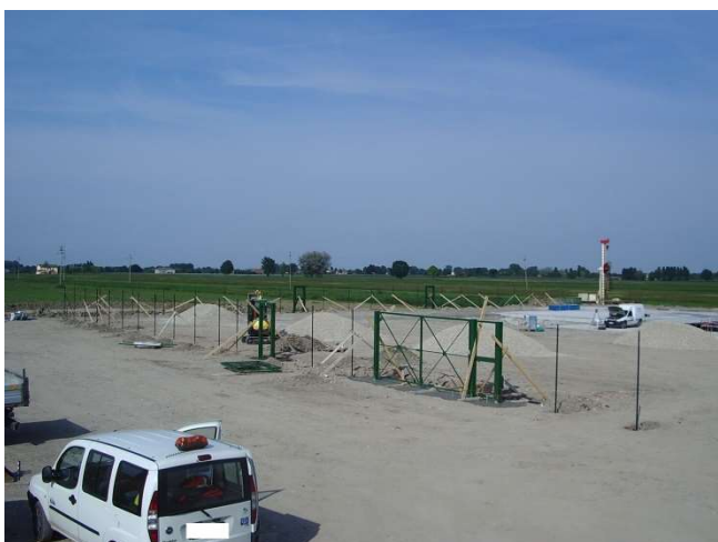
Foto raffigurante la posa del cancello carrabile con cancello pedonale annesso e posa di cancello per vie di fuga con maniglione antipánico in una postazione analoga
