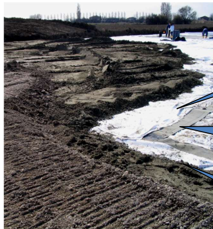
Foto raffiguranti fasi di posa del tessuto non tessuto con all'interno geomembrana sotto la massicciata in una postazione analoga
