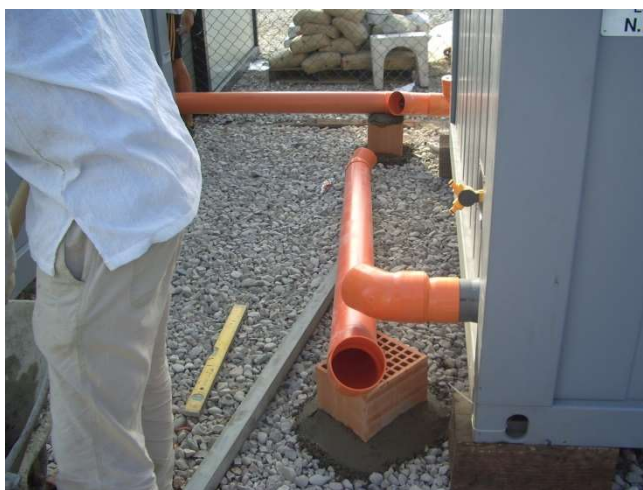
Foto raffigurante la posa della rete di scarichi dei servizi a disposizione degli operatori durante la perforazione: a perfetta tenuta idraulica mediante sigillatura dei giunti delle tubazioni in una postazione analoga
