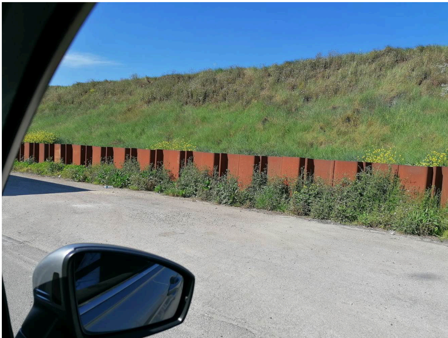
Foto 8 Dettaglio palancolato esterno Nadep Nord
