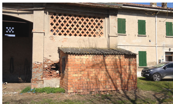
Fig. 4.1 – Fabbricati con coperture in amianto oggetto di rimozione e successiva demolizione
