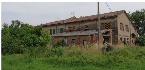
Fig. 4.1 – Fabbricati con coperture in amianto oggetto di rimozione e successiva demolizione
