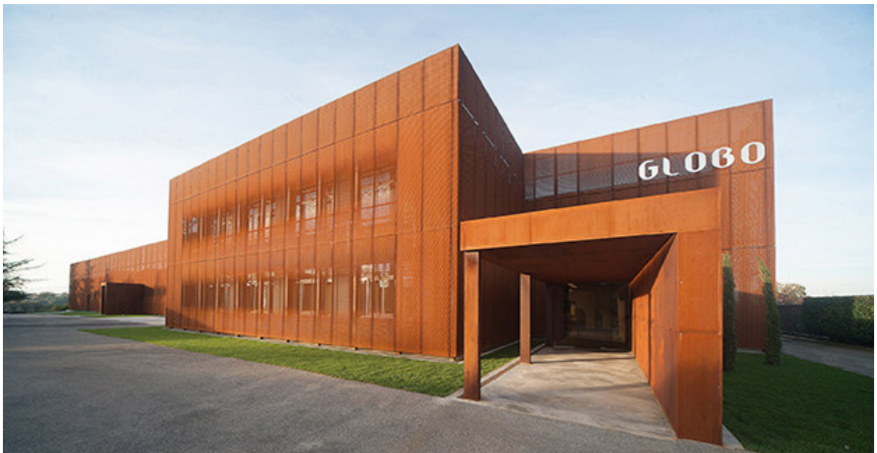
Figura 38 Esempio di lamiera stirata su struttura in c.a.
