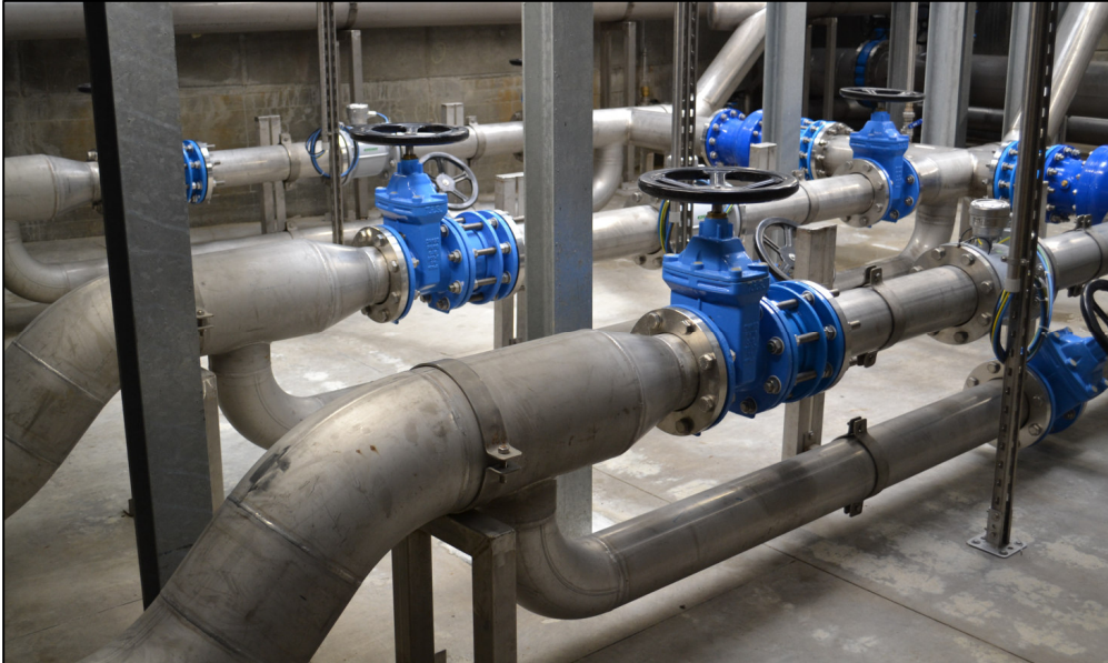
Figura 25 – Esempio piping, organi di manovra e misuratori di portata installati presso la centrale idrica di Luzzara, Reggio Emilia, di proprietà Ireti S.p.A.
