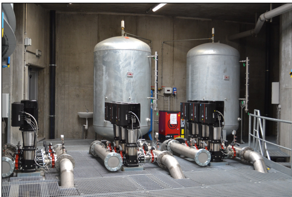
Figura 24 – Esempio gruppi di pressurizzazione con pompe centrifughe verticali multistadio installati presso la centrale idrica di Luzzara, Reggio Emilia, di proprietà Ireti S.p.A.
