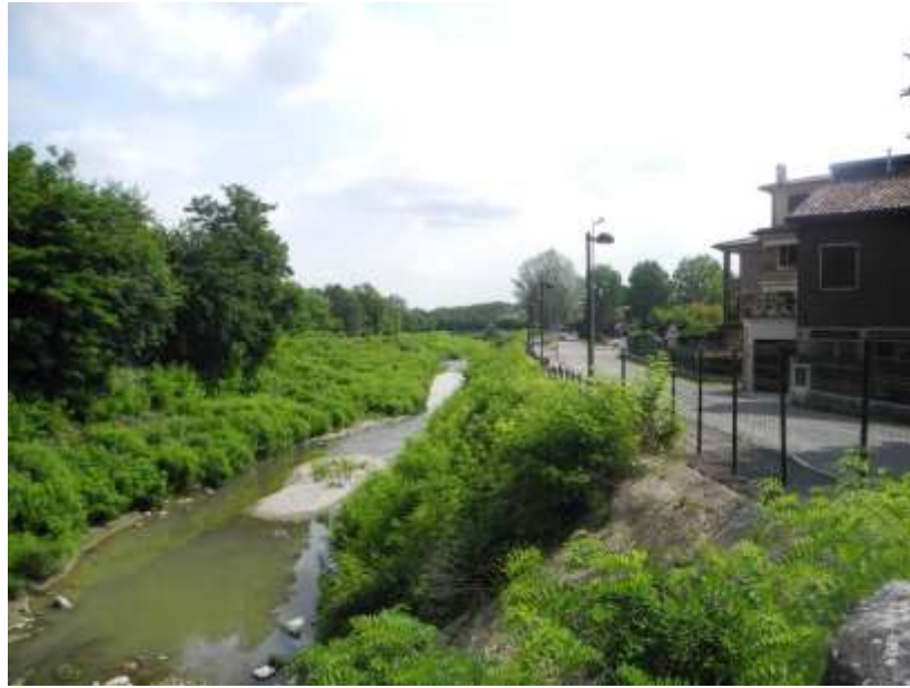
Figura 3 – Vista sponda destra con pendenza elevata a valle del ponte Salvaterra
