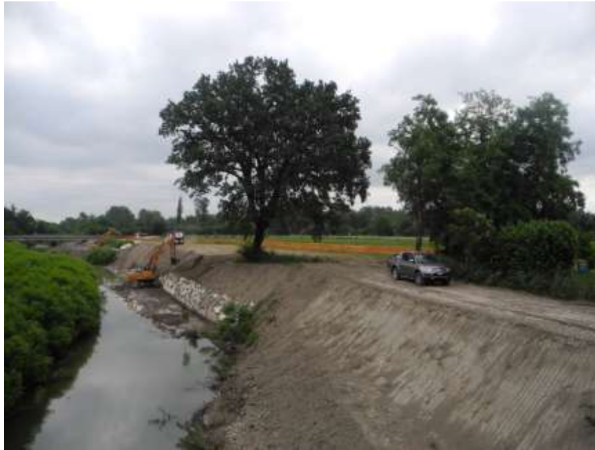
Figura 6 – Difesa di sponda destra compresa tra il ponte della SP51 e la passerella ciclabile di via Pedaggio Pedagna
