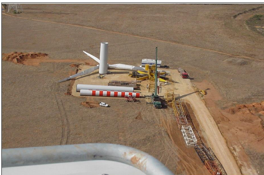
Foto 1. Piazzola per il montaggio dell'aerogeneratore
