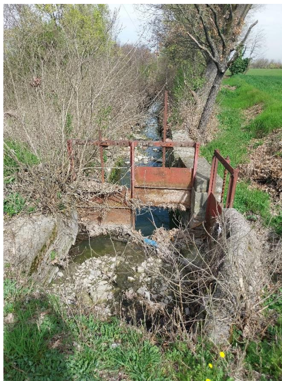
Fig.7: Cavo Maretto – Paratoie da demolire
