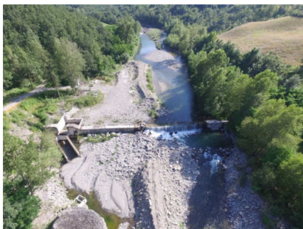
Fig. 1: viste della esistente briglia colassata di Molino Ca' Camoscio. L'impianto viene previsto in destra idraulica
