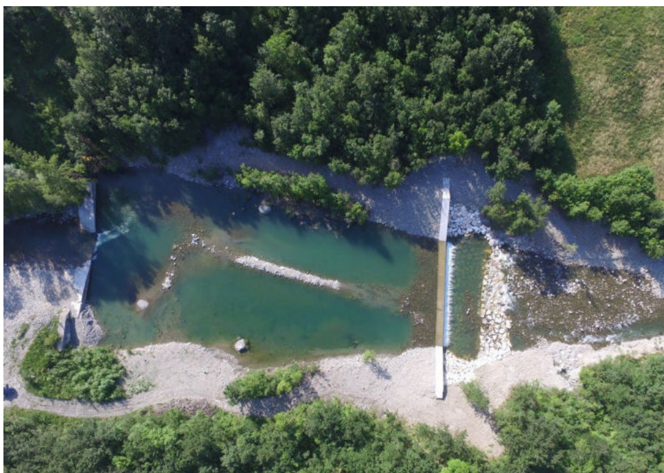
Fig. 2: Briglia colassata di Mulino Ca' Camoscio e a circa 100 m a valle la nuova briglia di recente costruzione. Si noti la zona di calma tra le briglie, la nuova vasca di dissipazione e controbriglia in massi ciclopici, la "rapida" a valle della controbriglia che sarà sempre caratterizzata da corrente veloce.
