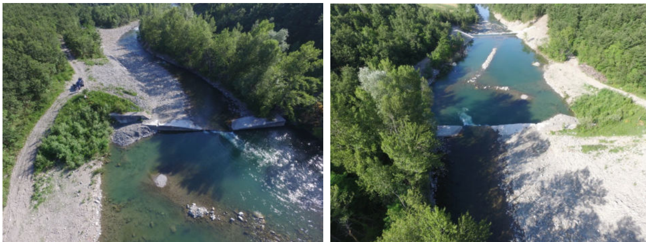
Fig. 1: viste della esistente briglia colassata di Mulino Ca' Camoscio. L'impianto viene previsto in destra idraulica
