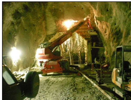
Foto 2: Fase di realizzazione della centinatura
