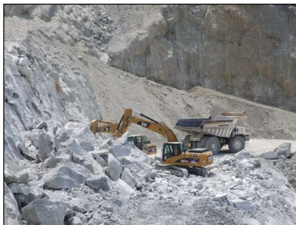
Figura 30: Operazioni di smarino
