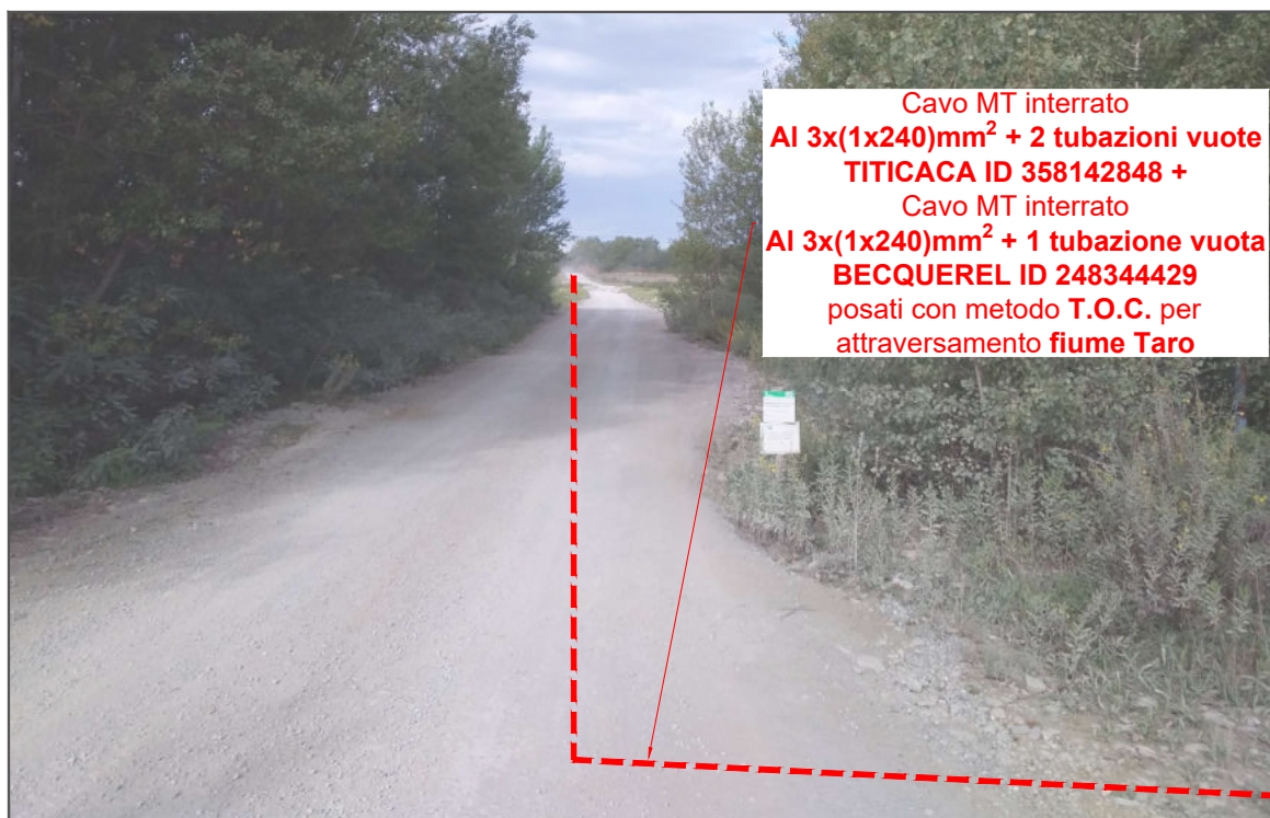
Foto 21: Nuova linea MT in partenza dalla cabina primaria CP COLLECCHIO in percorrenza lungo strada sterrata in proprietà privata in proseguimento di via Scodoncello e conseguente lancio TOC per attraversamento Fiume Taro
