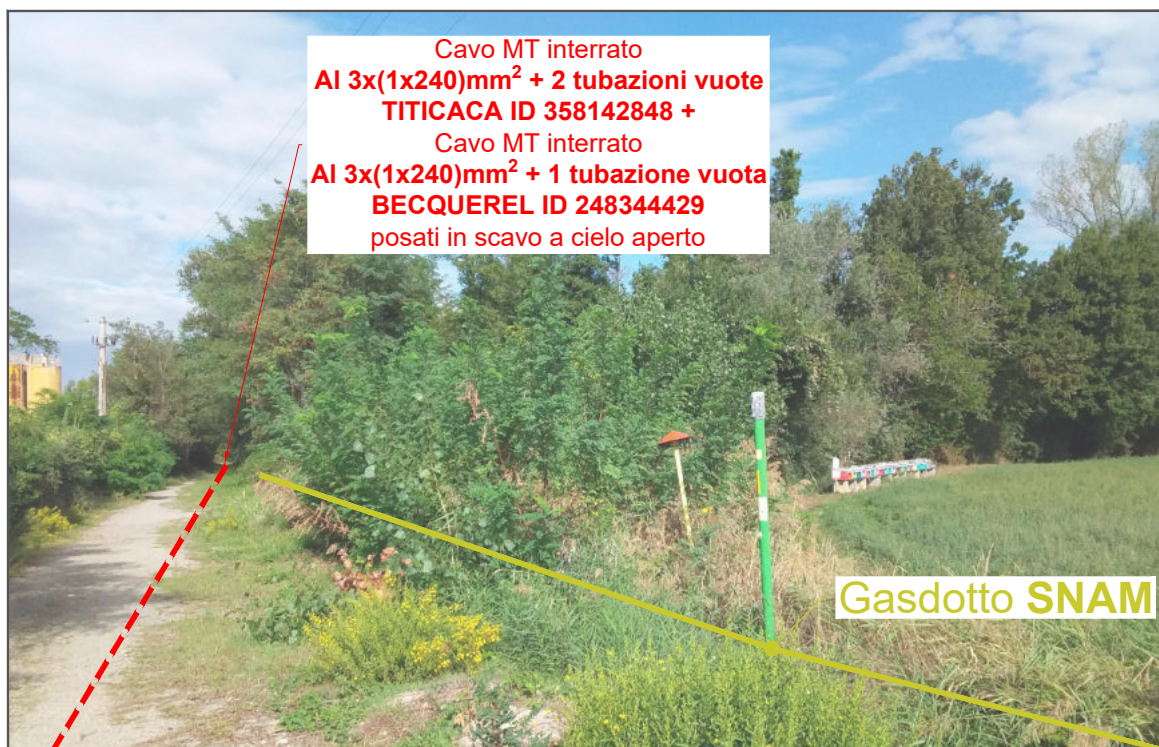
Foto 17: Nuova linea MT in partenza dalla cabina primaria CP COLLECCHIO in percorrenza lungo via Scodoncello ed in parallelismo a Gasodotto SNAM
