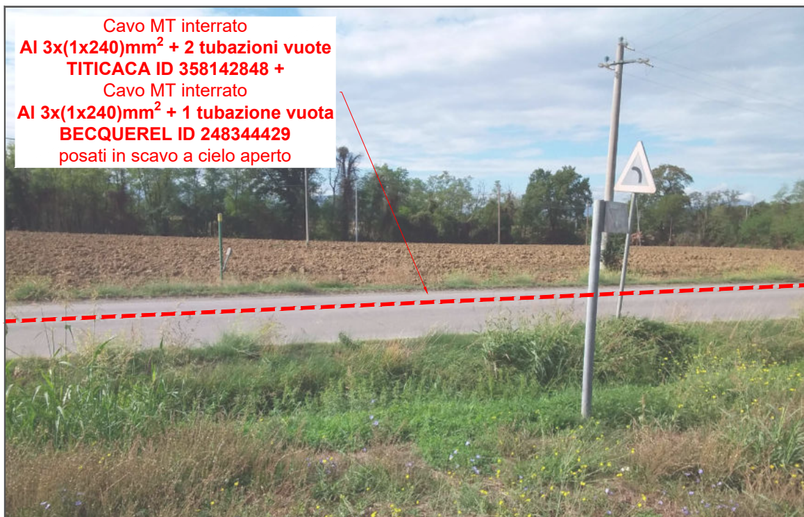
Foto 12: Nuova linea MT in partenza dalla cabina primaria CP COLLECCHIO in percorrenza lungo via Scodoncello e interferenza con Oleodotto POL
