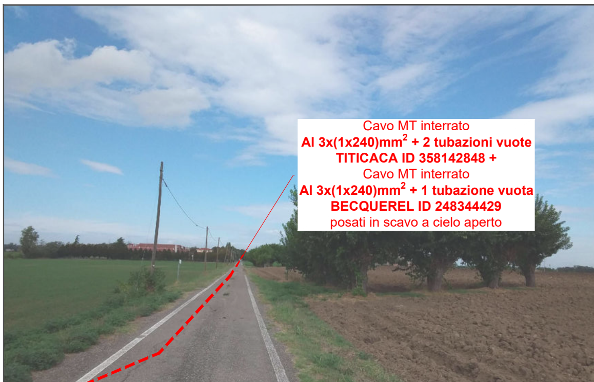
Foto 3: Nuova linea MT in partenza dalla cabina primaria CP COLLECCHIO in transito lungo Strada Varra Superiore, in interferenza con Oleodotto POL.
