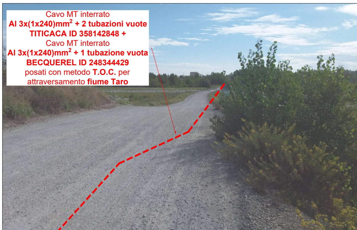
Foto 10: Nuova linea MT in partenza dalla cabina primaria CP COLLECCHIO in arrivo tramite lancio TOC per attraversamento Fiume Taro in via Ghiaie Superiori, Comune di Medesano
