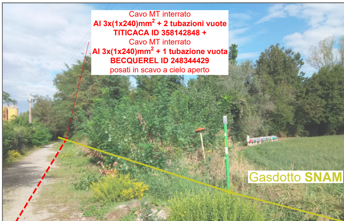
Foto 5: Nuova linea MT in partenza dalla cabina primaria CP COLLECCHIO in percorrenza lungo via Scodoncello e in attraversamento con Gasodotto SNAM
