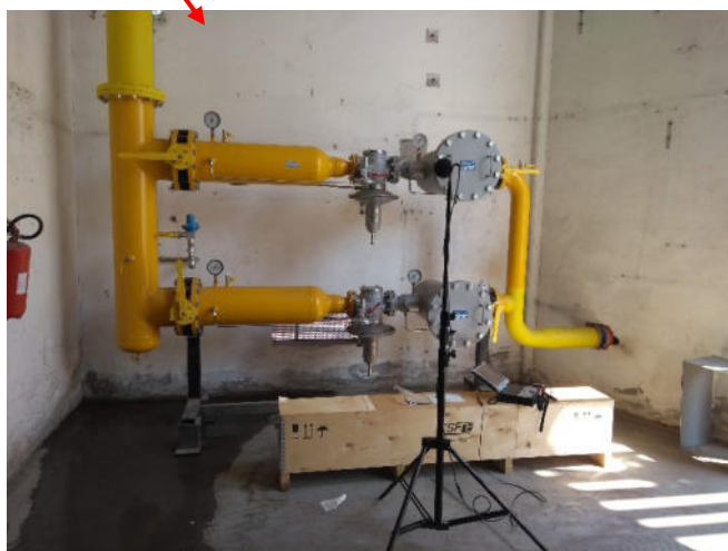
Impianto di decompressione
