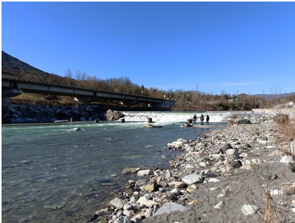
Figura 2-8. Vista della briglia da valle della stessa e della viabilità statale SS45 sopraelevata.
