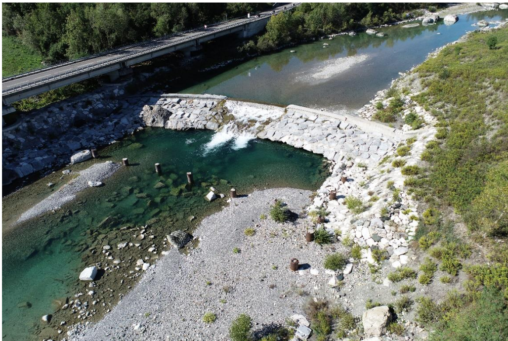
Figura 2-10. Vista della briglia da drone
