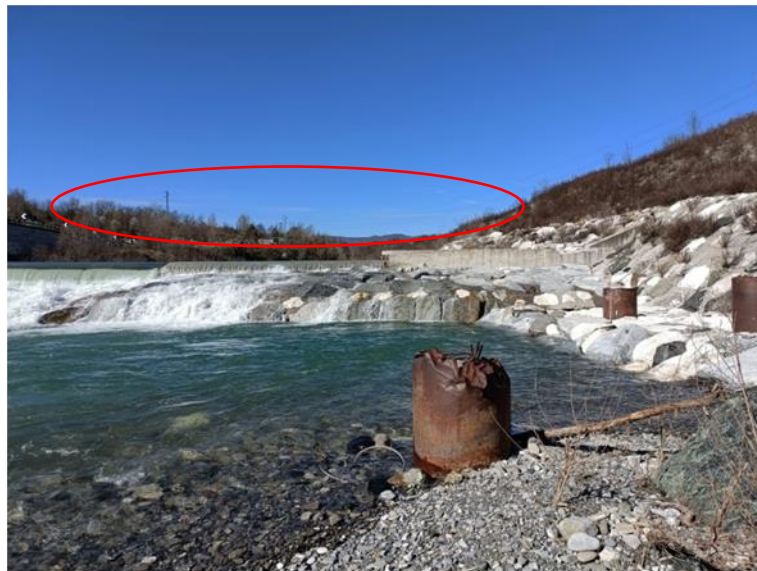
Figura 3-22 - Fotografia dell'area di intervento da sopralluogo con vista della linea elettrica MT
