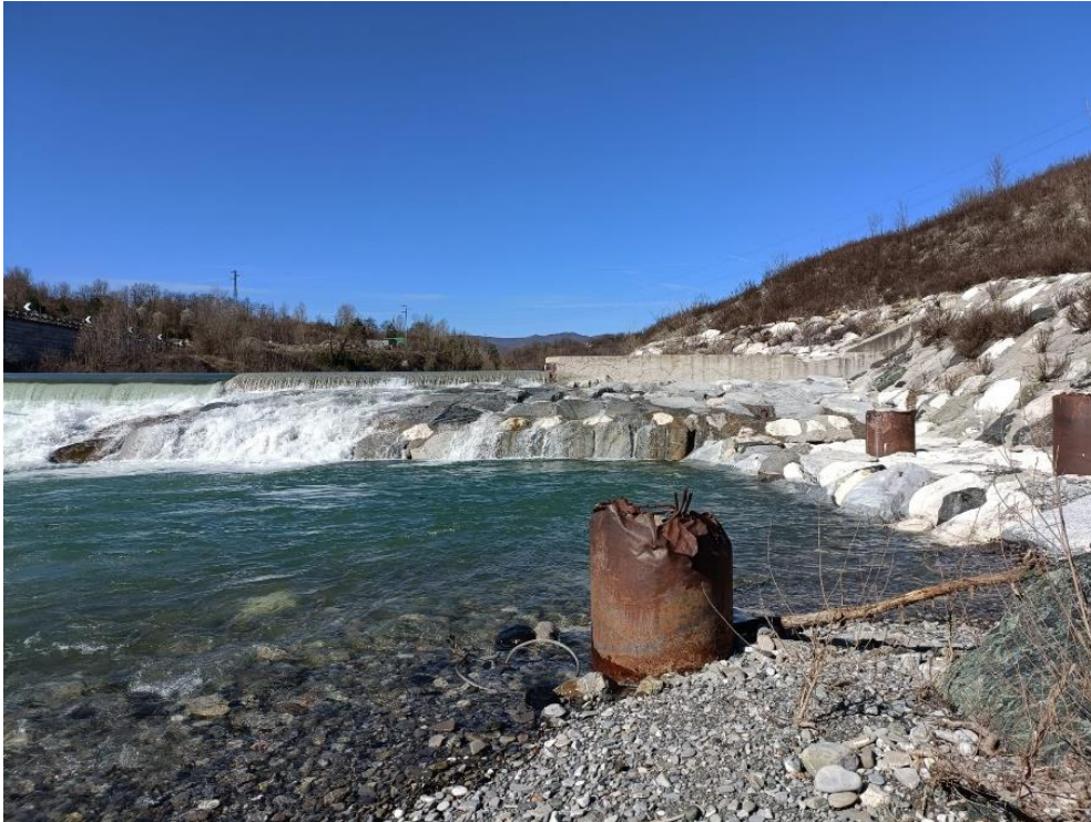
Figura 2-9. Vista della briglia da valle della stessa con individuazione di scogliera di protezione in sinistra idraulica e pile di dissipazione.
