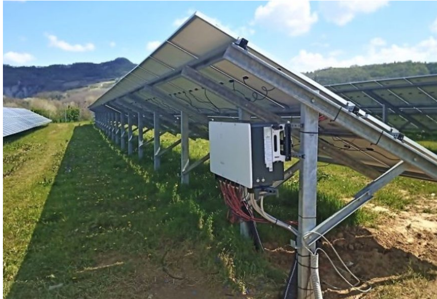
Figura 20: Esempio di cablaggio inverter di stringa
