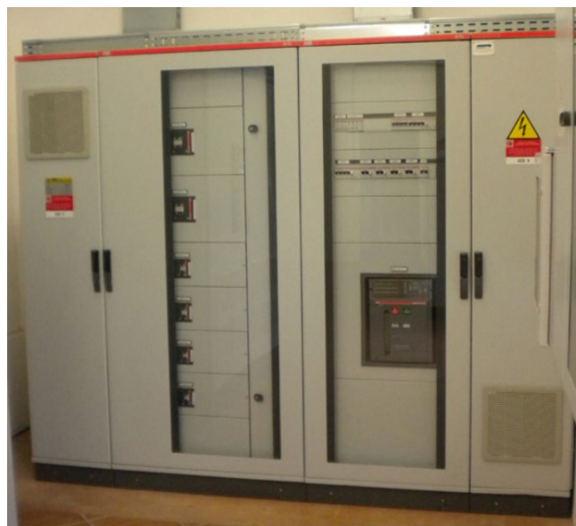
Figura 21: Quadro di parallelo inverter installato nella sezione BT delle power station
