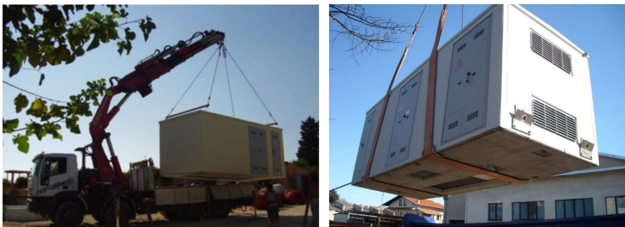
Figura 29: Rimozione delle cabine di raccolta e delle power station
