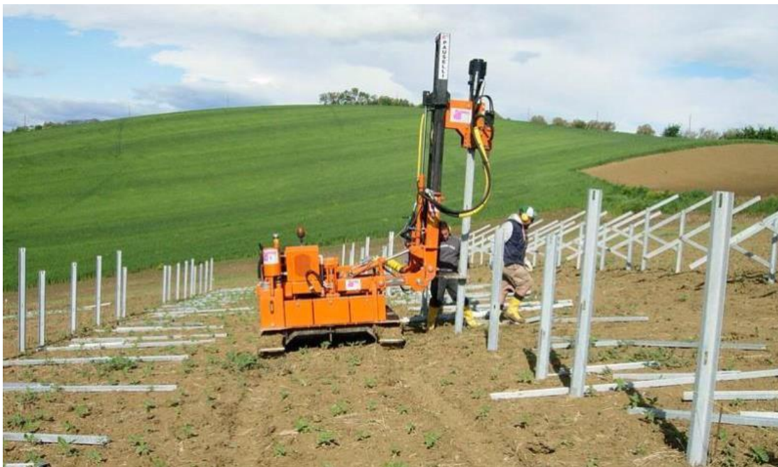
Figura 6 – Macchina battipali per l'ancoraggio delle strutture che non richiede opere di scavo
