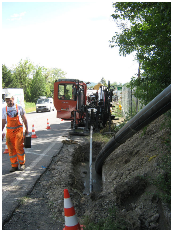
Figura 2 e 3 – Particolari di esecuzione della Trivellazione Orizzontale Controllata (T.O.C.).
