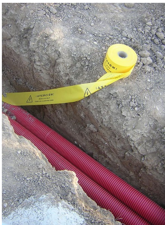
Figura 5 e 6 – Particolari di esecuzione della posa su scavo aperto
