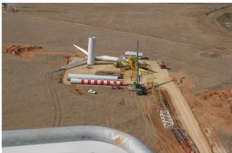
Figura 16 – Piazzola per il montaggio dell'aerogeneratore
