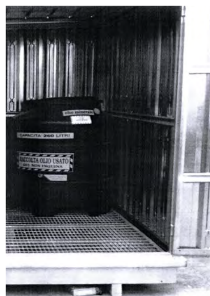
Figura 3: particolare interno del container. Si evidenzia il contenitori per gli oli e la pavimentazione dotata di vasca di raccolta
