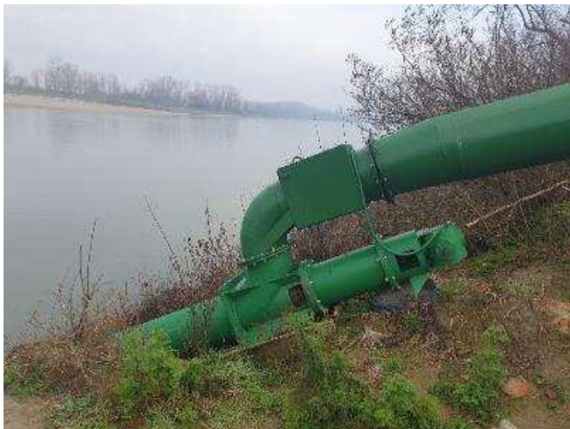
Foto 3 e Foto 4: vista della tubazione di mandata dall'alveo e dalla sponda
